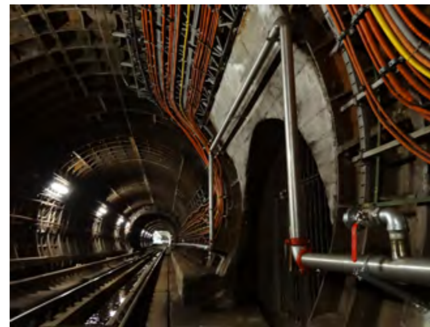
TUNELOVÝ VODOVOD S ODBĚRNÝM HYDRANTOVÝM MÍSTEM V MEZISTANIČNÍM ÚSEKU VYSOČANSKÁ – ČESKOMORAVSKÁ
