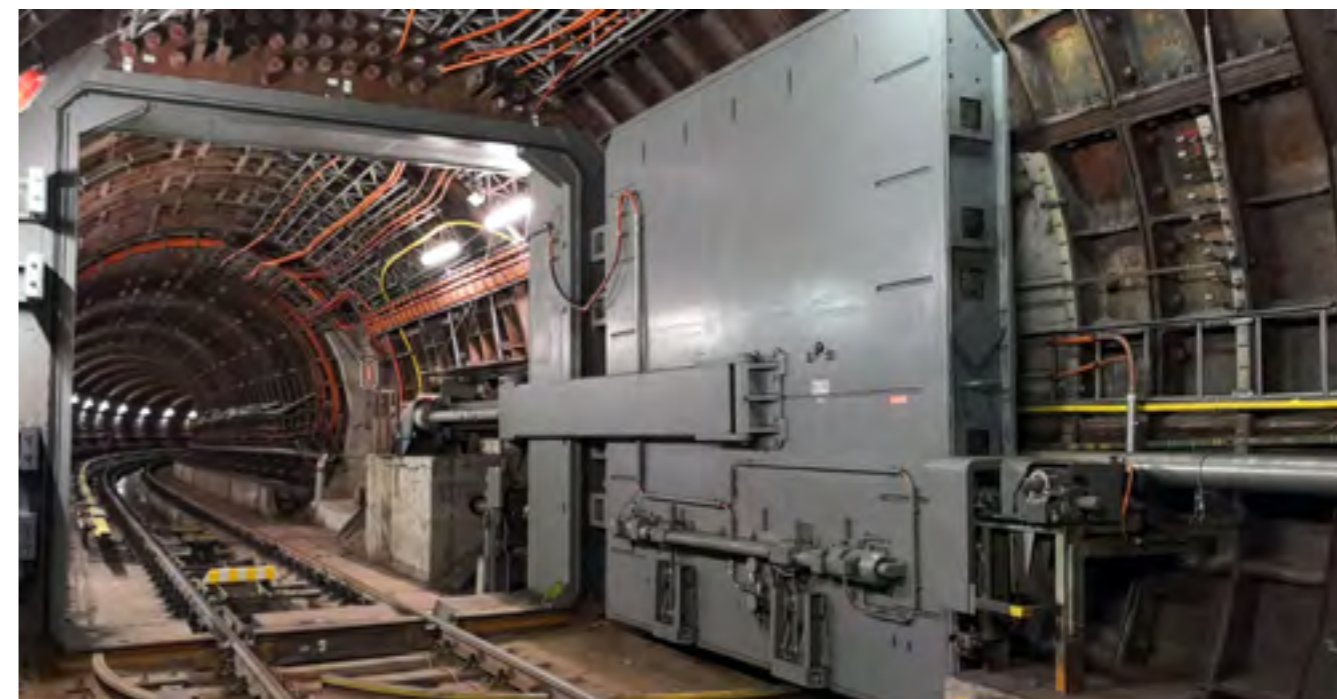
TRATOVÝ TLAKOVÝ UZÁVĚR ZT-76A NA B-C SPOJCE
