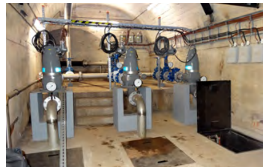
ZÁKLADNÍ NEFEKÁLNÍ ČERPACÍ STANICE V MEZISTANIČNÍM ÚSEKU FLORENC – KRŽÍKOVÁ
