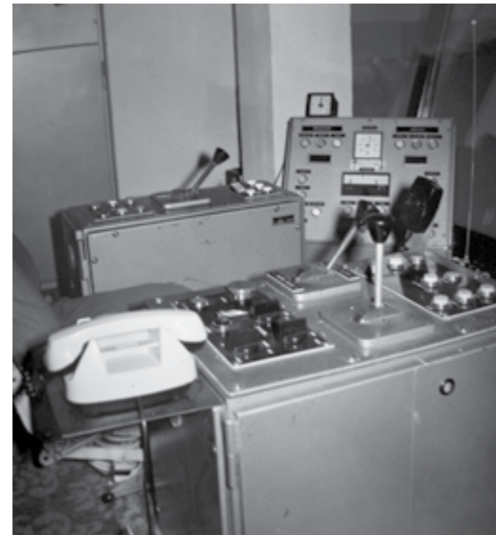
STANOVIŠTĚ STROJNÍKA LANOVKY V ROCE 1985...
