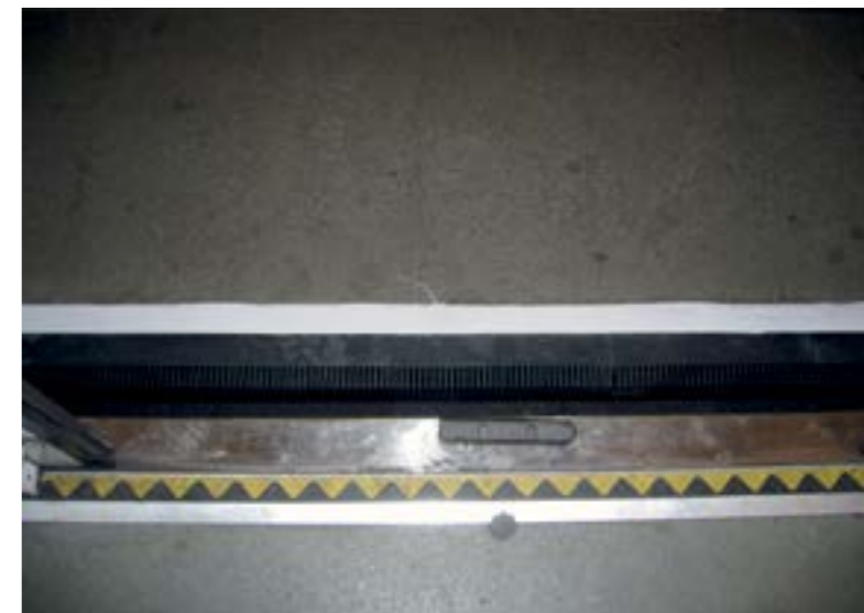
POHLED NA GAP FILLER Z VOZU SHORA SMĚREM K HRANĚ NÁSTUPIŠTĚ (BÍLE JE NATŘEN ÚHELNÍK OCELOVÉ HRANY NÁSTUPIŠTĚ)
