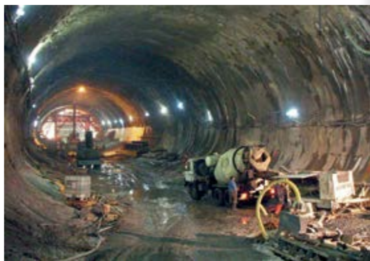
ZÁBĚR Z VÝSTAVBY STANICE KOBYLISY
