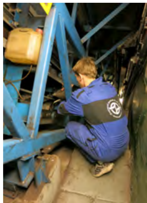
MECHANIK STŘEDISKA 244330 PŘI MAZÁNÍ ŘETĚZU POHYBLIVÝCH SCHODŮ Č. 068 VE STANICI HRADČANSKÁ
