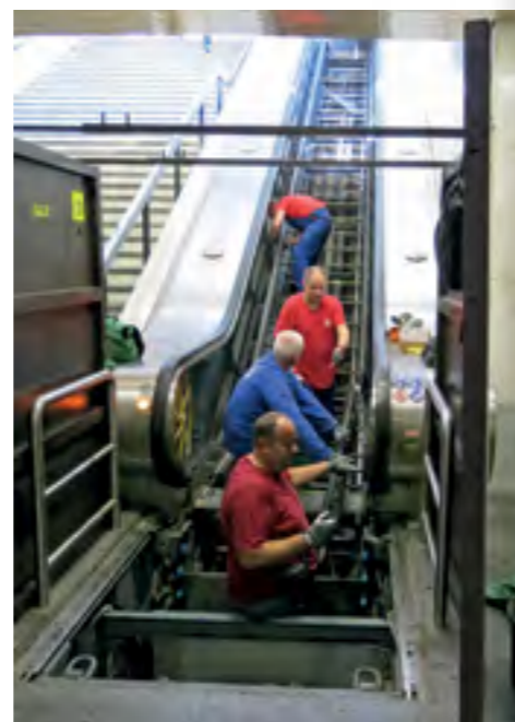
MECHANICI STŘEDISKA 244430 PŘI OPRAVĚ PODCHODOVÝCH POHYBLIVÝCH SCHODŮ Č. 110 VE STANICI DEJVICKÁ
