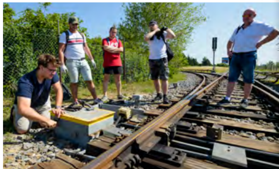
V PŘÍPADĚ PORUCHY MUSÍ PRACOVNÍK PŘIBLIŽNĚ 57X ZATOČIT KLIKOU, ABY VÝMĚNA BYLA PŘESTAVĚNA
