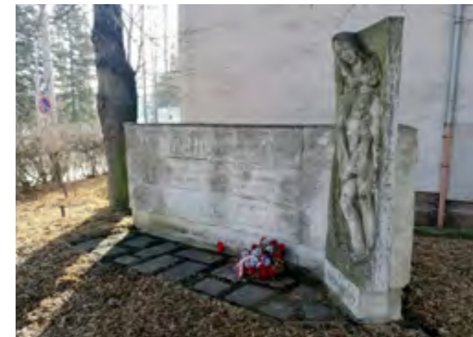
... A STAV PŘED RENOVAČÍ V ROCE 2019
