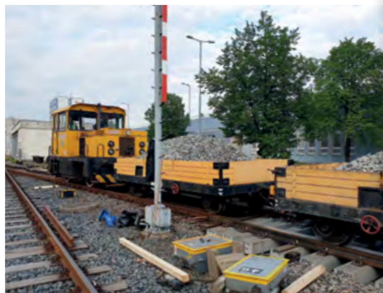
NÁVOZ ŠTĚRKU PRO ZASYPÁNÍ VÝHYBKY V DEPU KAČEROV
