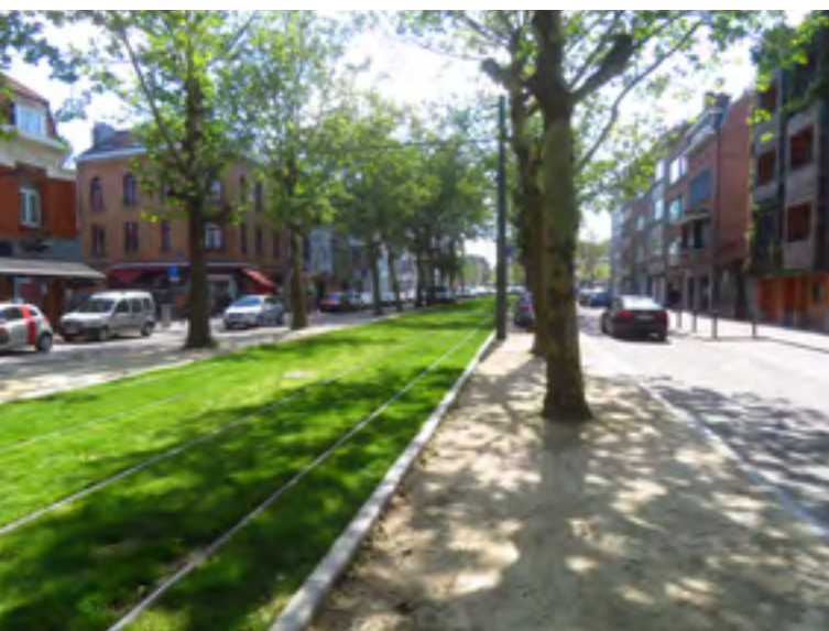
NOVÁ PODOBA ULICE S TRATÍ UPROSTŘED, PARKOVÁNÍM VOZIDEL MEZI STROMY NA MLATOVÉM POVRCHU USNADŇUJÍCÍM VSAKOVÁNÍ VODY...
