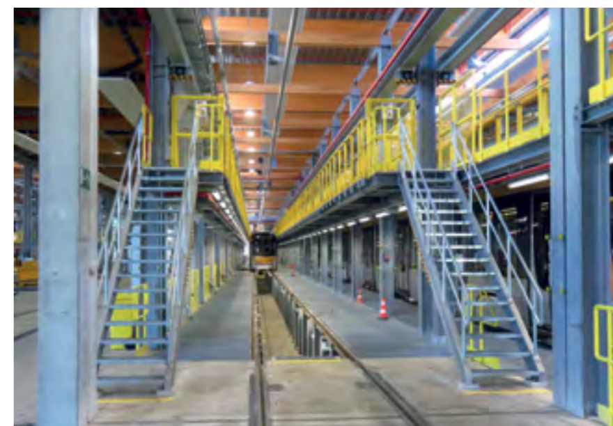
JEDNO Z DESETI STANIŠŤ ÚDRŽBY S PROHLÍDKOVOU JÁMOU A LÁVKAMI PRO PŘÍSTUP NA STŘEŠU VOZU
