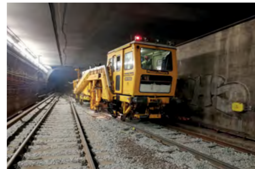
PODBÍJENÍ VÝHYBKY POMOCÍ AUTOMATICKÉ STROJNÍ PODBÍJEČKY
