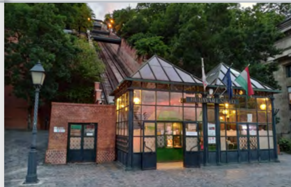
DOLNÍ STANICE HISTORICKÉ LANOVKY NA BUDÍNSKÝ HRAD
