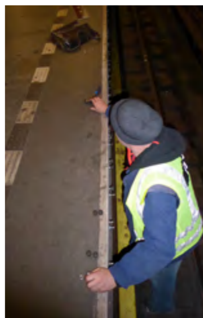
MONTÁŽ GAP FILLERU, TEDY GUMOVÉHO HŘEBENU PRO ZMENŠENÍ MEZERY MEZI VOZEM METRA A NÁSTUPNÍ HRANOU NÁSTUPIŠTĚ
