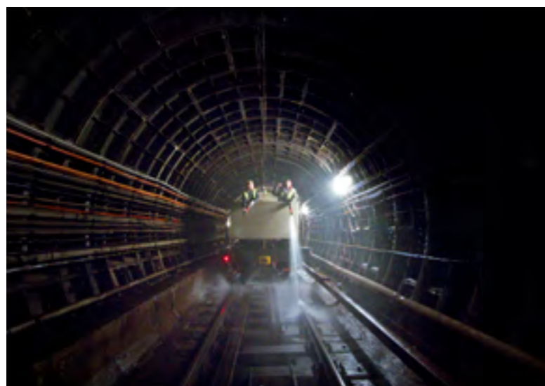
MYTÍ TUNELŮ POMOCÍ MYČÍ SOUPRAVY
