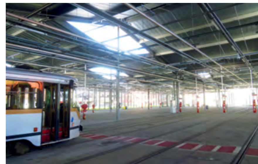
NA SNÍMKU ODSTAVNÉ ČÁSTI JE VIDĚT, ŽE TATO ČÁST VOZOVNY BYLA POSTAVENA JAKO OTEVŘENÁ
