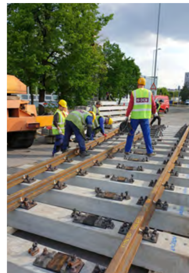
MONTÁŽ VÝHYBKŮ V DEPU KAČEROV
