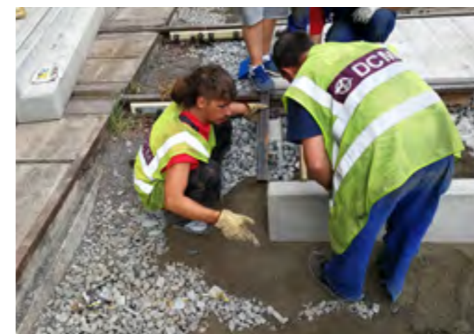
MONTÁŽ ROZEBÍRATELNÝCH PŘEJEZDŮ
