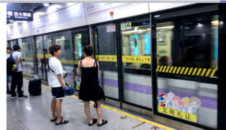
METRO V ŠANGHAJI MÁ VYBUDOVANÉ NÁSTUPIŠTNÍ STĚNY PŘED VSTUPY DO SOUPRAV
