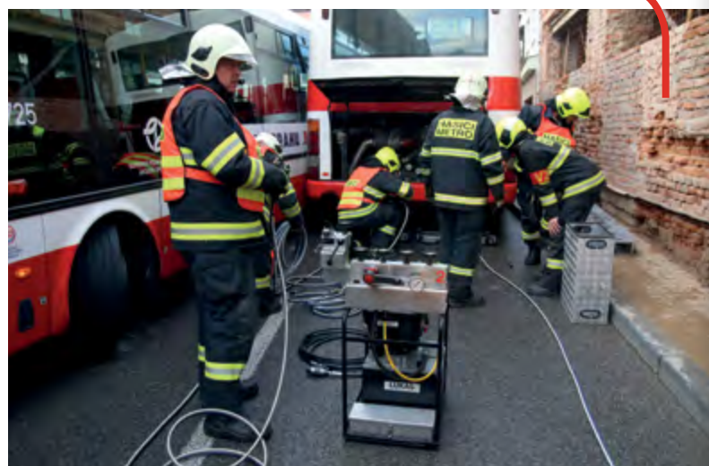
ZÁSAH Č. 457, LIPENCE – NAVZÁJEM ZAKLÍNĚNÉ KLOUBOVÉ AUTOBUSY V ÚZKÉ KOMUNIKACI; PROVEDEN BOČNÍ POSUN AUTOBUSU POMOCÍ HYDRAULICKÉHO ZAŘÍZENÍ LUKAS, AUTOBUSY OSVOBOZENY
