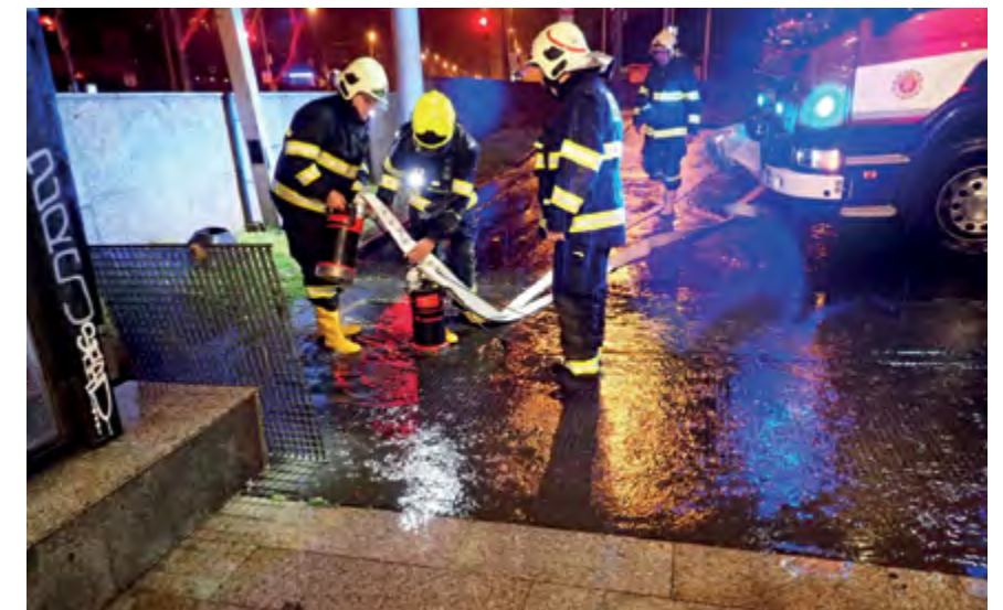
ZÁSAH Č. 256, STANICE METRA ŽELIVSKÉHO – UCAPANÁ KANALIZACE PO PŘÍVALOVÉM DEŠTI, VODA ZATĚKÁ DO STROJOVNY ESKALÁTORU; NASAZENA TROJICE ELEKTRICKÝCH KALOVÝCH ČERPADEL, KANALIZACE PROČIŠTĚNA, VODA POSTUPNĚ ODČERPÁNA ZE VŠECH ZATOPENÝCH PROSTOR
