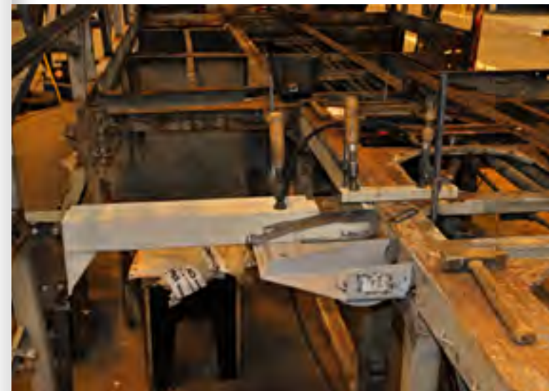
ŘÍJEN 2017: NAVAROVÁNÍ NOVÉ ČÁSTI RÁMU PODVOZKU PŘEDNÍ ČÁSTI
