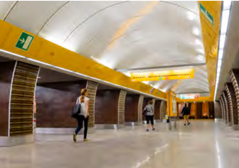
MODERNIZACE OSVĚTLENÍ STANICE METRA JINONICE BYLO PŘEDMĚTEM 31. VÝZVY OPERAČNÍHO PROGRAMU PRAHA – PÓL RŮSTU ČR
