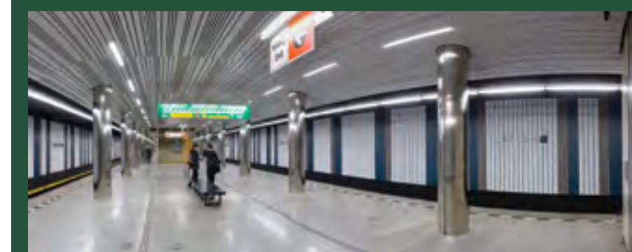
STĚNY ZA KOLEJIŠTĚM NA NÁSTUPIŠTI V PŮVODNÍM I V NOVÉM BAREVNÉM PODÁNÍ. NOVÉ OSVĚTLENÍ SPOLU SE SVĚTLEJŠÍM PODHLEDEM CELKOVĚ PROSVĚTLILO (ZÁBĚRY Z ČERVNA A ŘÍJNA 2017 A POTÉ Z BŘEZNA 2018).
