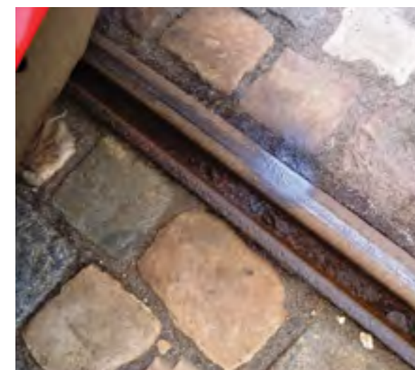
MODIFIKÁTOR TŘENÍ NANESENÝ NA HLAVU KOLEJNICE
