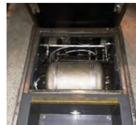
VZDUŠNÍK UMÍSTĚNÝ POD PODLAHOU KABINY ŘIDIČE
