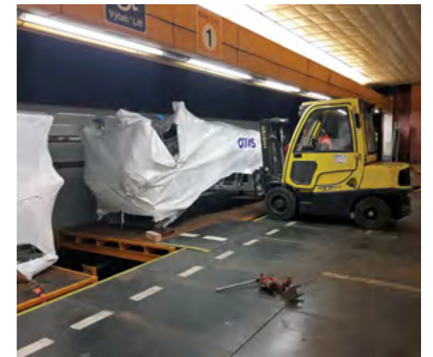
DOPRAVA ČÁSTI RAMENE ESKALÁTORU NA PALMOVKU V PŘEPRAVNÍ VÝLUCE
