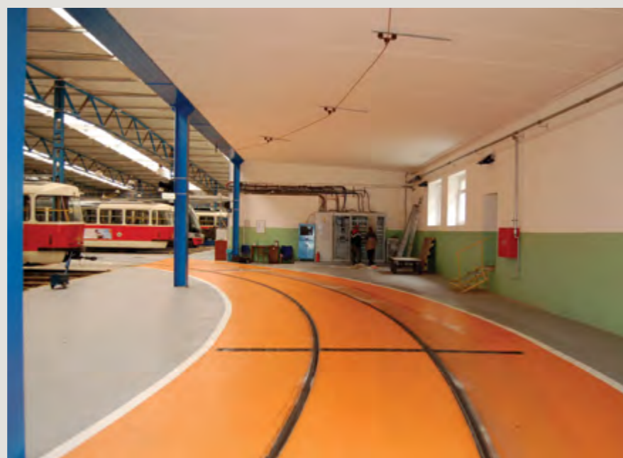
KURIÓZITOU VOKOVICKÉ VOZOVNY JE OD ROKU 2015 KOLEJOVÁ SMYČKA UVNITŘ HALY. V ŽÁDNÉ JINÉ VOZOVNĚ NĚCO TAKOVÉHO NENAJDEME. FOTOGRAFIE, KTEROU POŘÍDIL LUKÁŠ SRB, PATŘÍ DO PRACOVNÍ DOKUMENTACE STAVEB ÚTVARU 250110 ODD. SPRÁVA TT A SPECIÁLNÍCH STAVEB DCT. VZNIKLA 26. ŘÍJNA 2015 TĚSNĚ PO DOKONČENÍ STAVBY
