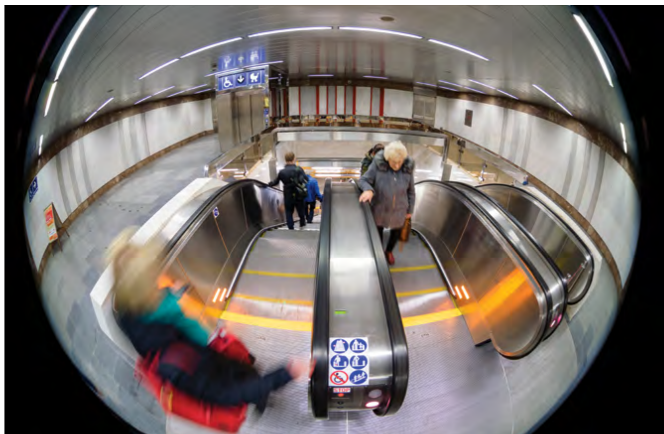
MODERNIZACE ESKALÁTORŮ VE STANICI PALMOVKA - ZÁPAD - VYUŽITÁ VÝZVA Č. 13
