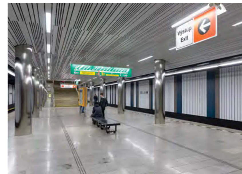
MODERNIZACE OSVĚTLENÍ STANICE METRA SKALKA – VYUŽITÁ VÝZVA Č. 31
