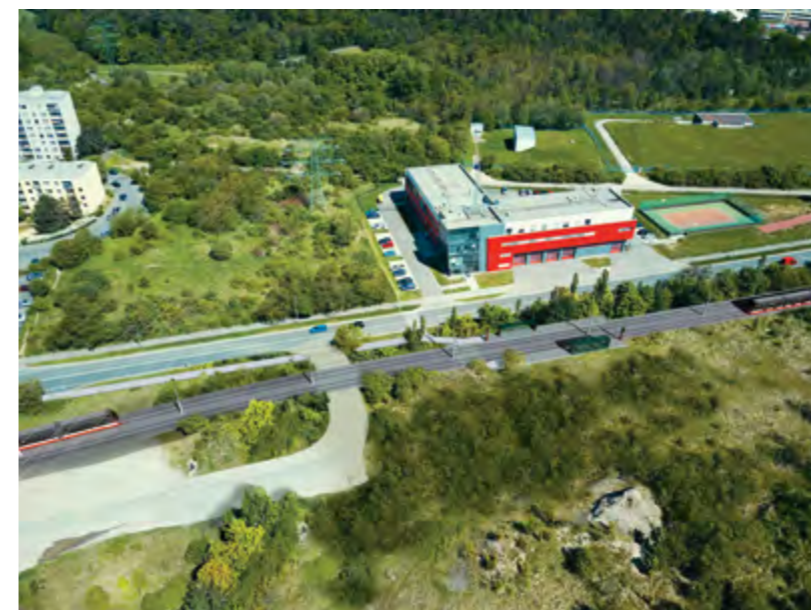
A VYHLÁŠENÁ VÝZVA Č. 53 JEŠTĚ JEDNOU – DŮLEŽITÁ PRO STAVBU TRATĚ DO LIBUŠE
