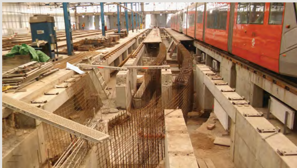
ROZSÁHLÁ REKONSTRUKCE VOZOVNY SE V ROCE 2013 TÝKALA I TZV. NOVÝCH KOZLÍKŮ
