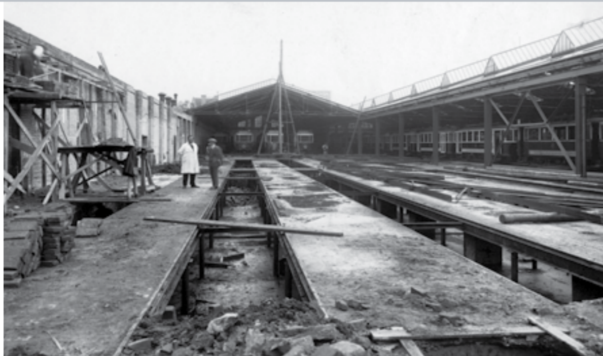
POHLED NA STAVENIŠTĚ NOVÉ PRVNÍ LODI STRAŠNICKÉ VOZOVNY
