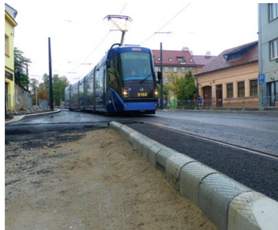
VE STŘEDNÍ ČÁSTI ZENKLOVY JEŠTĚ NEJSOU DOKONČENY VŠECHNY PRÁCE NA VOZOVKÁCH A CHODNÍCÍCH. NEJVÍCE SE PRACUJE MEZI ZASTÁVKOU VOSMÍKOVÝCH A U KŘÍŽE
