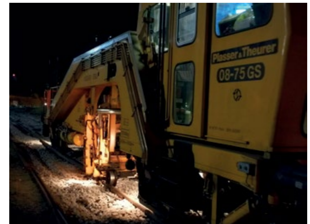
DEPO ZLIČÍN – ZKUŠEBNÍ TRATĚ MÁ ZA SEBOU ROVNĚŽ VÝMĚNU PRAŽCŮ
