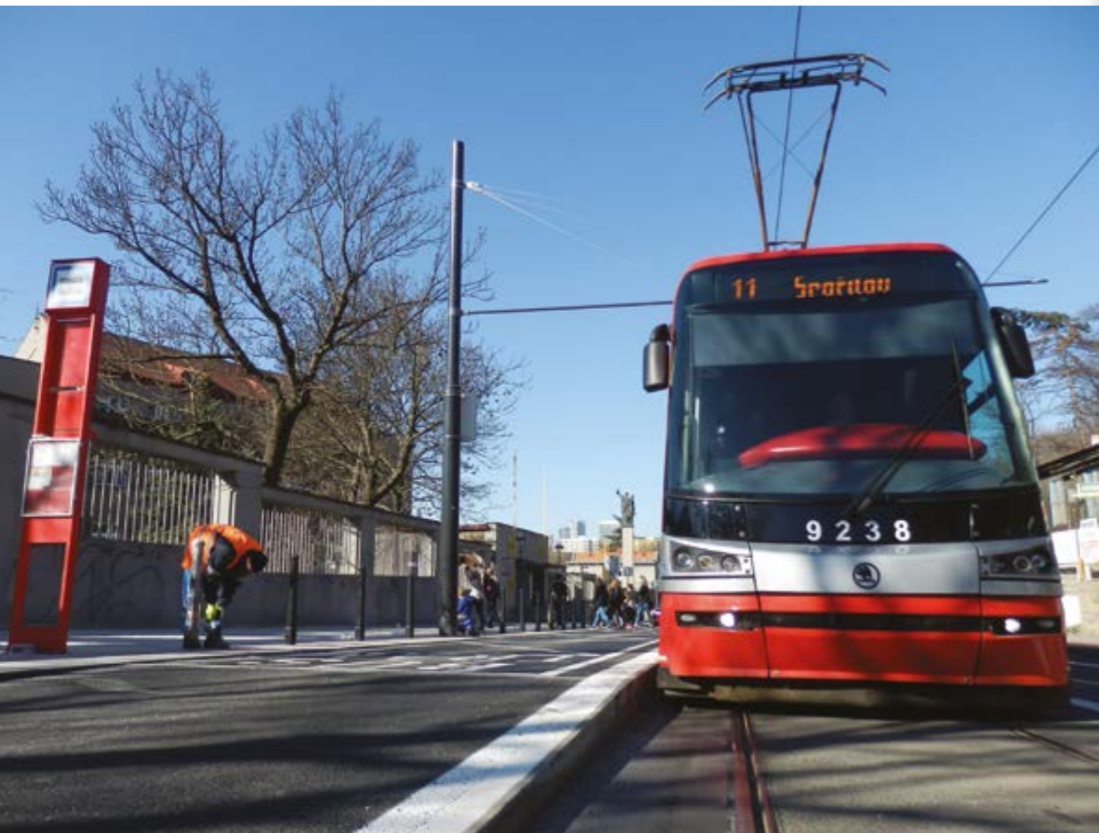
VÍDEŇSKÁ ZASTÁVKA PLYNÁRNA MICHLE Z CENTRA VHODNĚ KOMBINUJE POŽADAVKY NA BEZBARIÉROVOST A PREFERENCI MHD. TRAMVAJE A AUTOBUSY MAJÍ PROSTOR ODDĚLENÝ OD VOZOVKY PRO OSTATNÍ DOPRAVU, KTERÁ JE VEDENA PO ZVÝŠENÉ NÁSTUPNÍ HRANĚ
