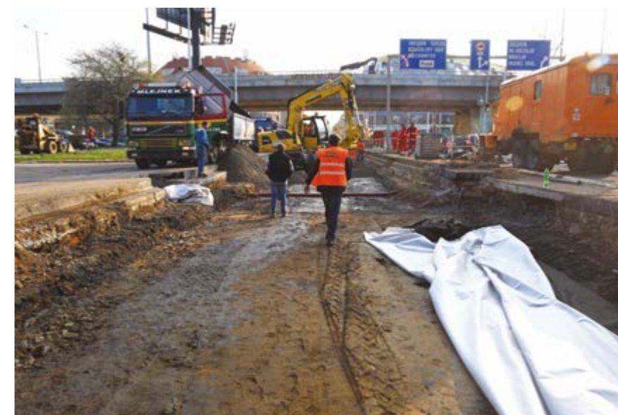
NEJDŮLEŽITĚJŠÍ ÚSEK CELÉ STAVBY: SOKOLOVSKÁ MEZI BALABENKOU A ULICÍ U BALABENKY (29. 3. 2017). NEDÁ SE TRAMVAJÍ OBJET, TAKŽE STAVBA ODŘÍZLA VOZOVNU HLOUBĚTÍN. DÍLO SE PODAŘILO STIHNOUT ANI NE ZA TŘI TÝDNY
