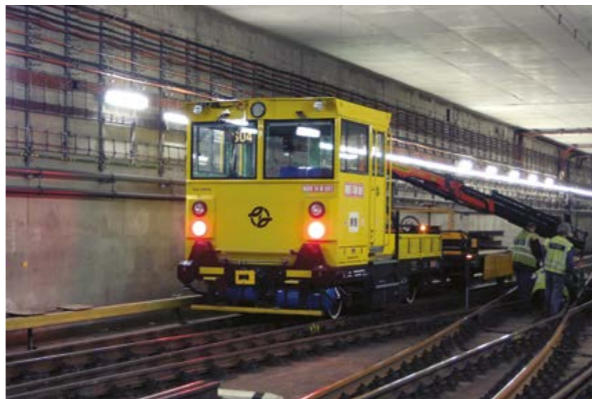
VÝMĚNA SRDČOVKY NA DVOJITÉ KOLEJOVÉ SPOJCE VE STANICI ČERNÝ MOST, 27. 3. 2014
