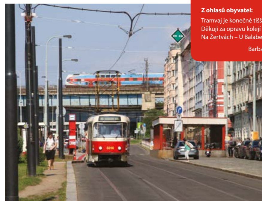
NEJVIDITELNĚJŠÍ ČÁSTI REKONSTRUOVANÉ TRAMVAJOVÉ TRATI JE ULICE NA ŽERTVÁCH
