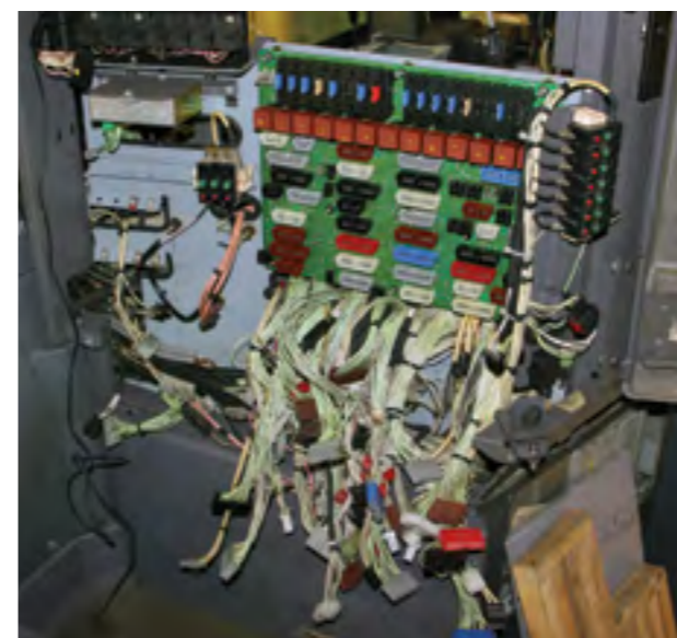
OPRAVA ELEKTROINSTALACE HLAVNÍHO ROZVADĚČE (13. 6. 2016)
