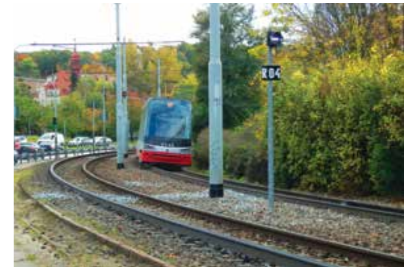
ZAJIŠTĚNÍ NEPŘEHLEDNÉHO ÚSEKU PŘED VÝHYBKOU. PŘI PRŮJEZDU TRAMVAJE EV. Č. 9246 KOLEM PRAŽCOVÉHO NÁVĚSTIDLA DOŠLO KE ZMĚNĚ SIGNÁLU NA STŮJ. DALŠÍ VLAK MŮŽE VJET DO ÚSEKU AŽ POTÉ, CO JEJ TENTO OPUSTÍ
