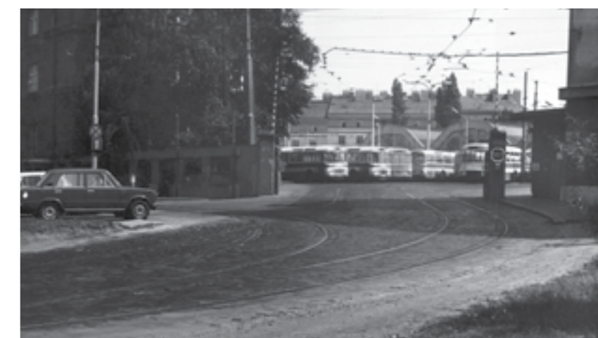
AUTOBUSY SDÍLELY S TRAMVAJEMI VOZOVNU DO 15. SRPNA 1982, KDY SE PŘESTĚHOVALY DO GARÁŽE DEJVICE (SNÍMEK ZHRUBA ROK PŘED STĚHOVÁNÍM)
