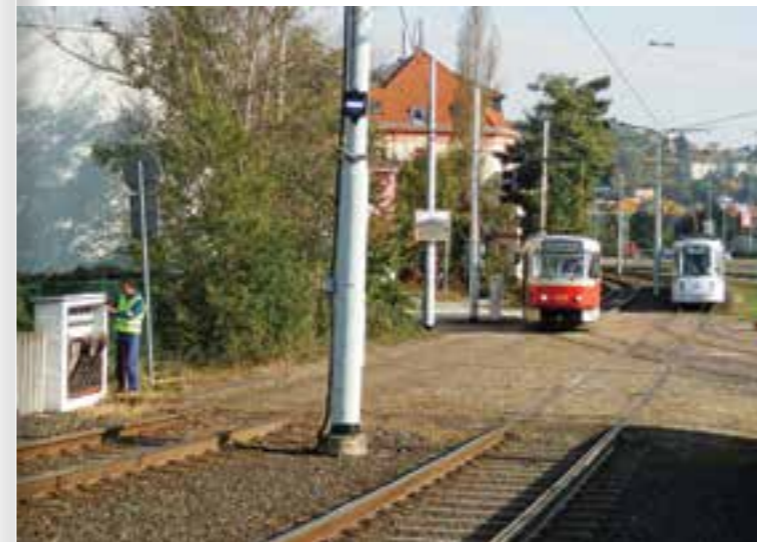
POKUD JE VE SMĚRU Z CENTRA UZAMKNUTA A ZABLOKOVÁNA VÝHYBKA VLEVO DO SMYČKY, VLAK VE SMĚRU DO CENTRA NESMÍ POKRAČOVAT V JÍZDĚ, COŽ JE SIGNALIZOVÁNO PRAŽCOVÝM NÁVĚSTIDLEM
