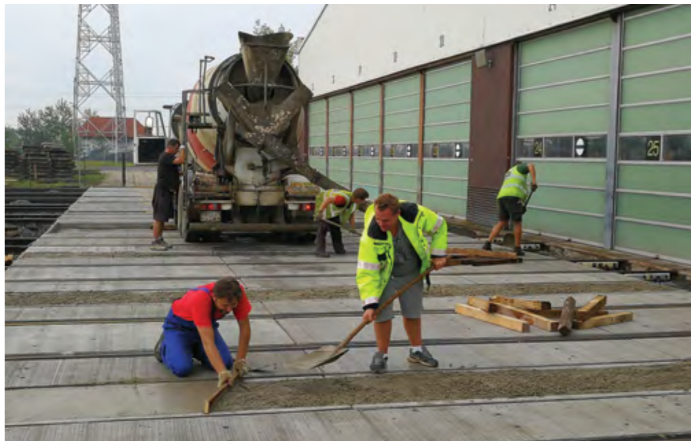
BETONÁŽ VRCHNÍ VRSTVY VÝPLŇOVÝCH BETONŮ NA POŽÁRNÍ KOMUNIKACI PŘED HALOU DEPA ZLIČÍN
