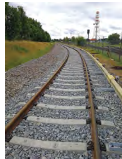
DOKONČENÁ KOLEJ Č. 5A ZLIČÍNSKÉHO DEPA – S BETONOVÝMI PRAŽCI
