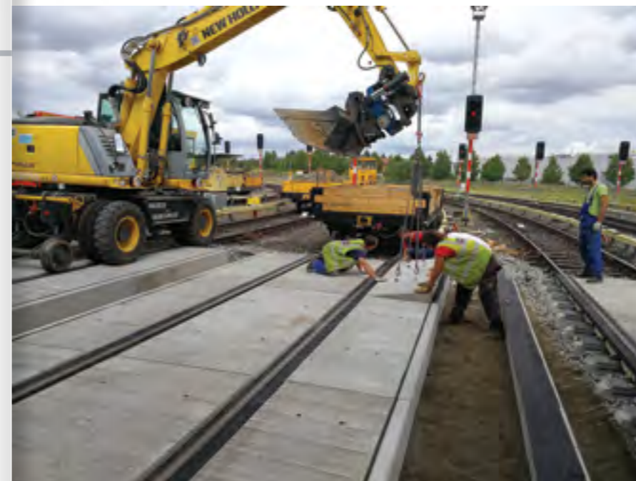
POKLÁDKA VNĚJŠÍCH PANELŮ NA POŽÁRNÍ KOMUNIKACI NA ZLIČÍNĚ
