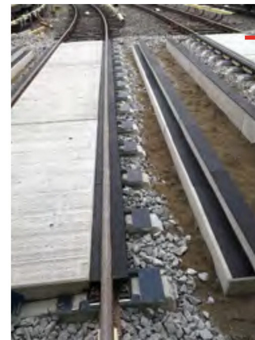
ZÁVĚRNÉ ZÍDKY PŘIPRAVENÉ NA POKLÁDKU VNĚJŠÍCH PANELŮ
