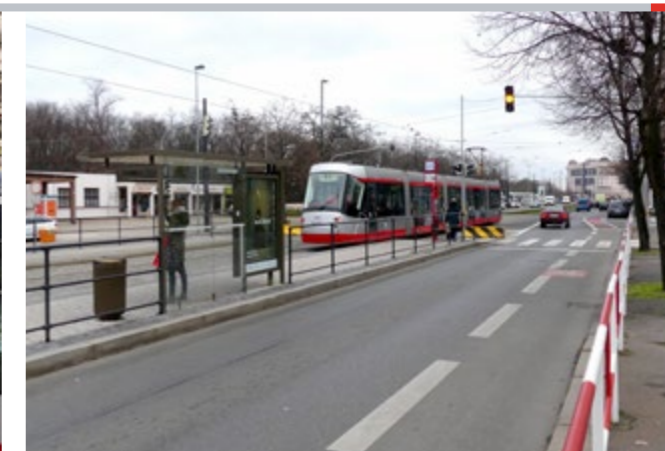
V ROCE 2019 BYLA DOKONČENA ÚPRAVA SSZ 3.319 VINOHRADSKÁ – NÁM. JIŘÍHO Z LOBKOVIC, KTEROU VYVOLALA REKONSTRUKCE TRAMVAJOVÉ TRATI. JEDNOU Z DŘÍVE ZVAŽOVANÝCH MOŽNOSTÍ BYLO I ZRUŠENÍ SIGNALIZACE. NAKONEC BYLO PROJEDNÁNO JEJÍ ZACHOVÁNÍ A ZAVEDENÍ PREFERENCI TRAMVAJÍ. VLAK VE SMĚRU Z CENTRA PŘÁVĚ OPUSTIL ZASTÁVKU A SIGNALIZACE UKONČILA VOLNO. NA SIGNALIZACI FUNGUJE ROVNĚŽ PREFERENCI CHODCŮ PRO LEPŠÍ PŘÍSTUP NA ZASTÁVKU V PŘÍPADĚ PŘÍJEZDU TRAMVAJE
