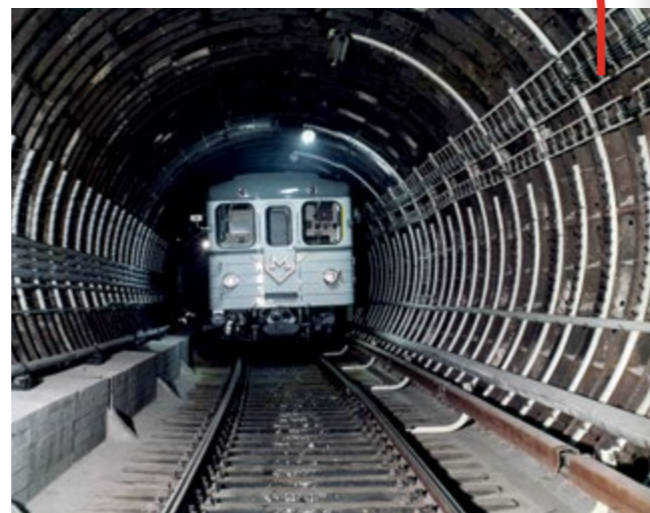
JIŽ V ROCE 1973 BYLA POŘÍZENÁ JEDNA Z PRVNÍCH FOTOGRAFIÍ VOZU EČS V TUNELU PRAŽSKÉHO METRA
