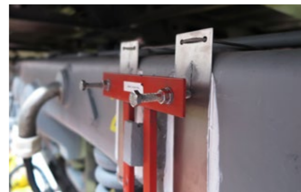
PRO KONSTRUKCI DRŽÁKU APLIKÁTORU A PRO STANOVENÍ JEHO MEZNÍ VZDÁLENOSTI OD PLOCHY KOLA BYLO NUTNÉ PROVOZNĚ OVĚŘIT MÍRU STLAČENÍ PRŮJIN PŘI DYNAMICKÉM ÚČINKU JÍZDY VLAKU S CESTUJÍCÍMI. K TOMU BYLA SESTROJENA TZV. „MĚŘICÍ PODCHYTKA“
