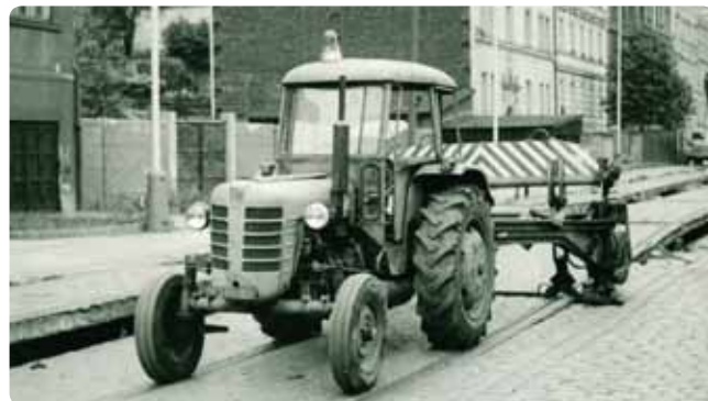
Velmi zajímavá souprava traktoru s hydraulickým vytrhávačem kolejnic. Pravda, dnes hledíme na takovouto praxi asi se značným údivem. V dané době však přinášela vedle časové úspory též výraznou úlevu od fyzicky značně namáhavé práce. Přesto byl tento způsob využíván jen nedlouhou dobu. Místem, kde se to vše odehrávalo, je Radlická ulice. 13. 7. 1971.
