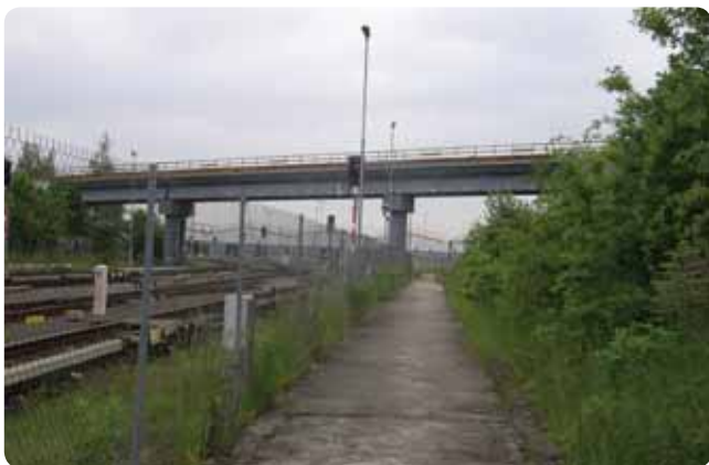
Pohled na konstrukci mostu.
