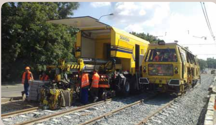
Železniční techniku (svářecí stroj a podbíječku) při práci u Hotelu Golf zachytil Petr Mašek.
