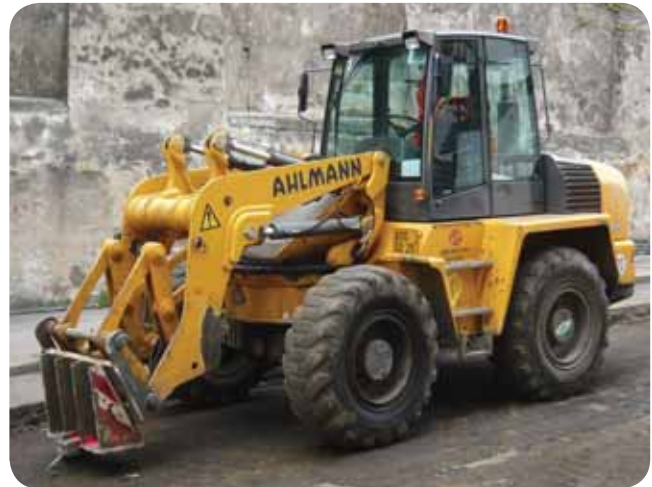
Další z výkonných strojů potřebných při opravách a rekonstrukcích tratí. Jeho velkou výhodou je univerzálnost použití. Snímek byl pořízen ve Vyšehradské ulici. 3. 9. 2010
