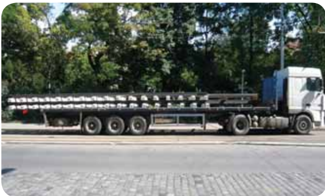
Jednou z technologických novinek při rekonstrukčních pracích je přeprava předem smontovaných kolejových polí přímo na místo určení. Ta na snímku z Karlova náměstí budou uložena na křižovatce Moráň. 4. 9. 2010
