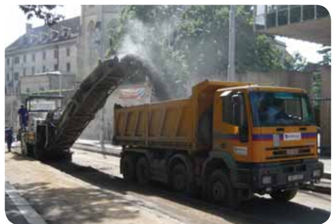
Velké urychlení renovačních prací představuje strojní frézování staré podkladové vrstvy tramvajové tratě. Nejinak tomu bylo i ve Vyšehradské ulici. 4. 9. 2010
