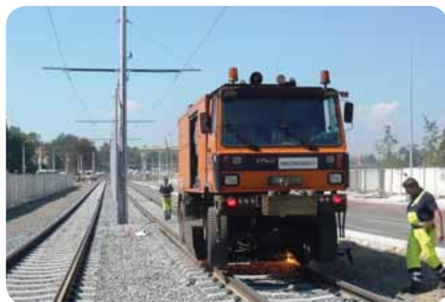
Broušení nových kolejnic na ulici Milady Horákové. 20. 8. 2010
