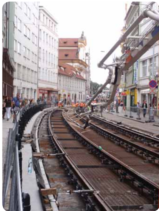
Staveniště ve Spálené ulici bylo velmi stísněné, což nejvíce vyniklo při betonáži desky.
