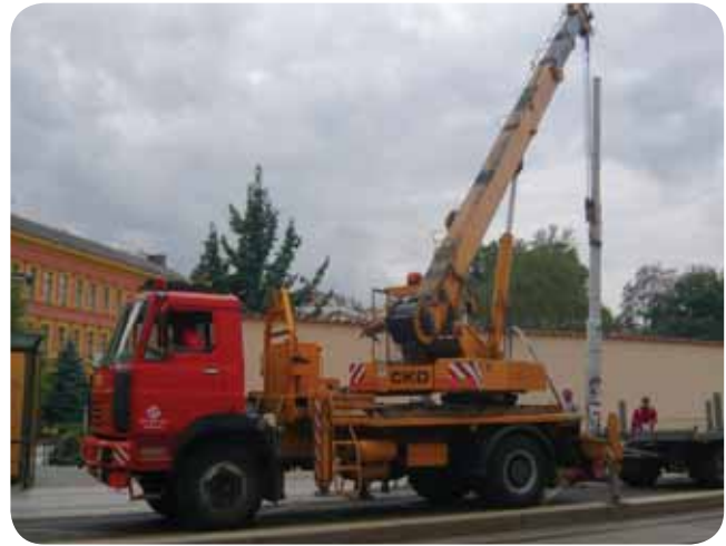
Ani obnova trakčního vedení v ulici Na slupi se neobešla bez pomoci autojeřábu. 3. 9. 2010
