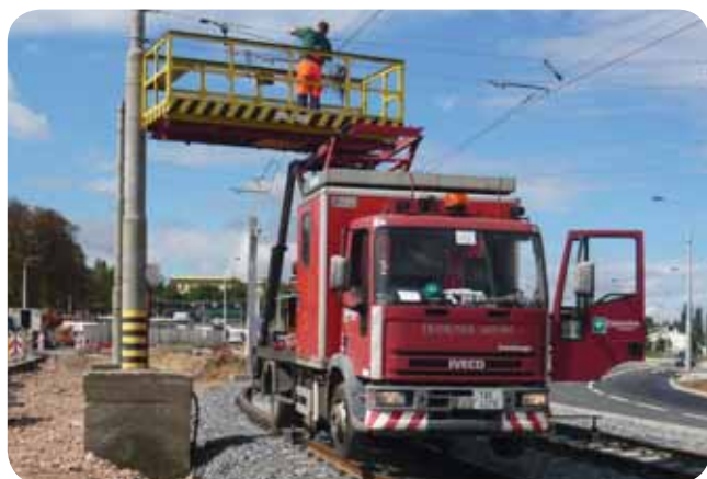
Pracovníci firmy Elektroline při úpravě trolejového vedení u křižovatky Prašný most. 24. 8. 2010
