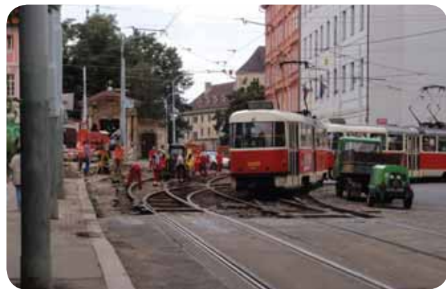
V pátek 3. září 2010 na témže místě probíhaly přípravné práce pro výměnu rozvětvení.
