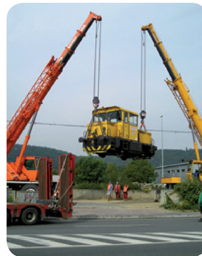
V Modřanech tahala šterkovací vozík lokomotiva z metra. Jeřáby jí skládají z návěsu na koleje u Černého koně
