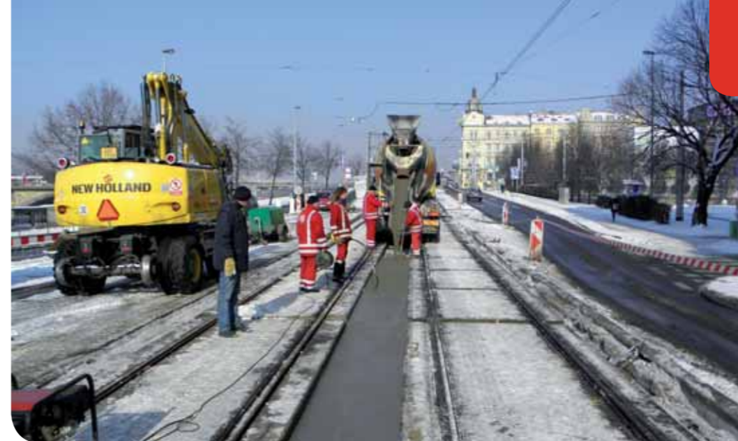
Za složitých klimatických podmínek probíhala na Rašínově nabřeží betonáž prostoru mezi panely. Použita byla speciální směs
