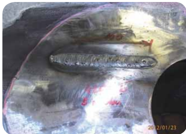
Místo trhliny po opravě, před konečným zabroušením do roviny
