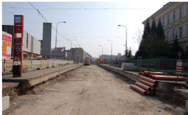
Snímek z počátku rekonstrukce tratě v místě zastávky Nádraží Holešovice.
