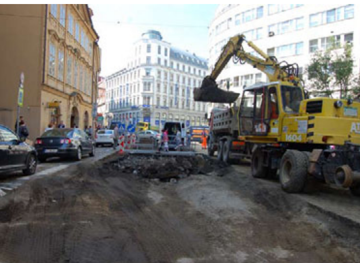
Zemní práce ve Vodičkově ulici.
