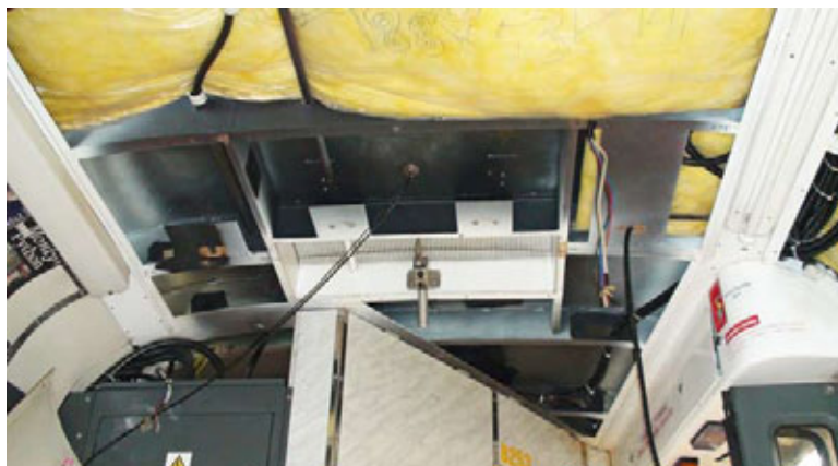
Pohled ke stropu za kabinou řidiče tramvaje T3R.PLF v době montáže kabeláže.
