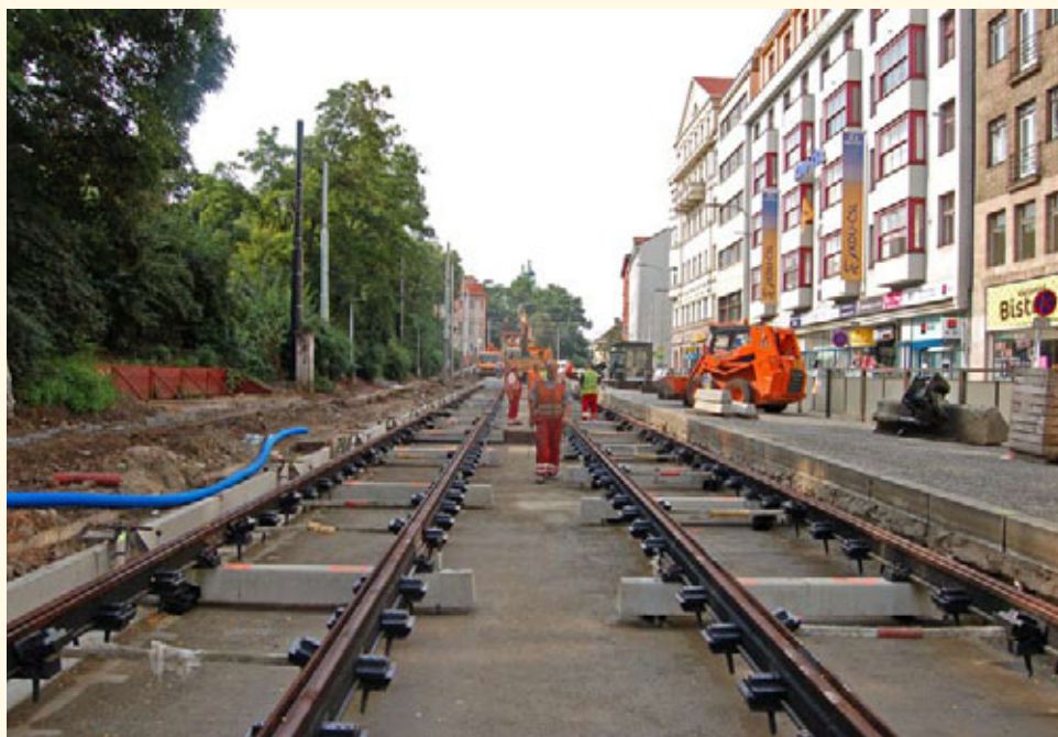
Tramvajová trať mezi Resslovou ulicí a Moráni ve fázi před betonáží.
