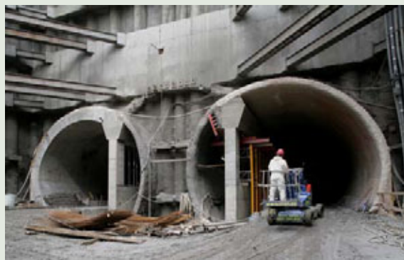
Stanice Nádraží Veleslavín po provedení ražby tunelů.
