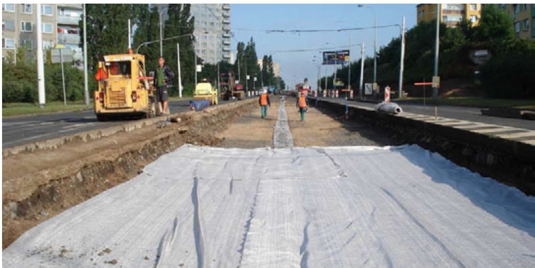
Z počátečních stavebních prací (nad křižovatkou Švehlova – Prácheňská).
