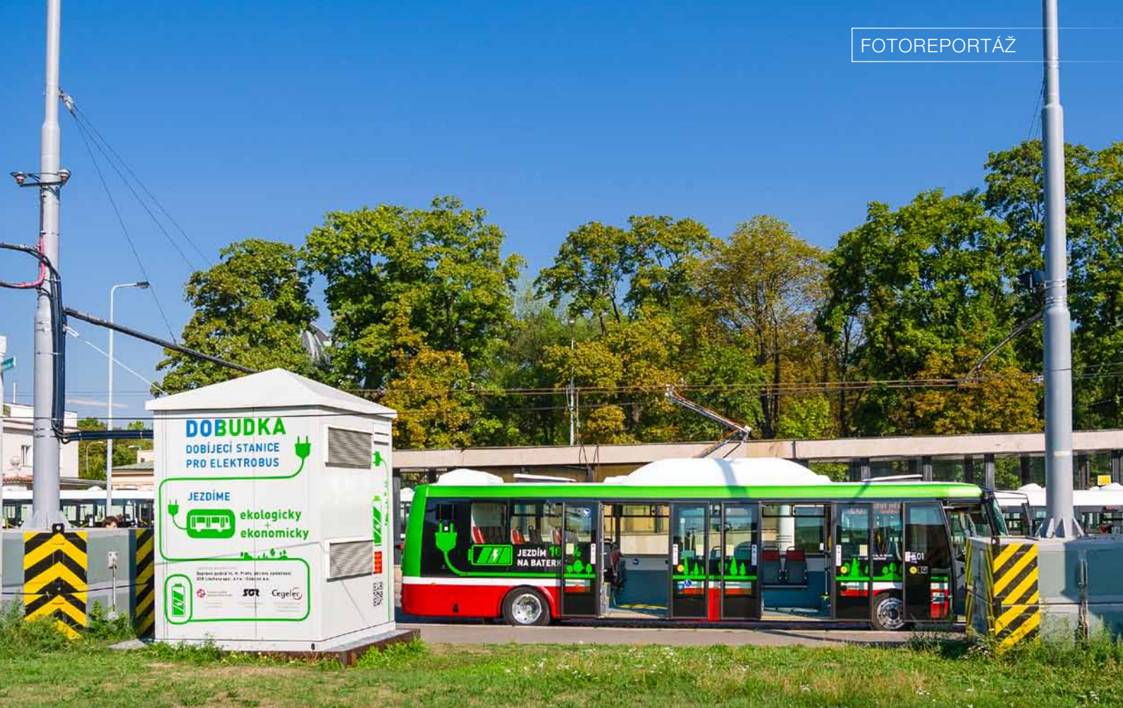
Nahoře: Dobíjecí místo s galvanickým oddělovačem a sloupy dvupólového trolejového vedení na Želivského.
