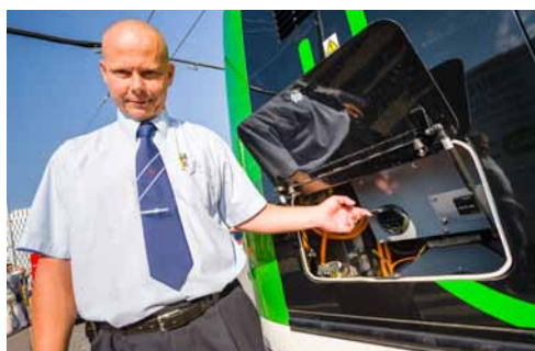
Nahoře: Řidič Martin Mrázek ukazuje zásuvku 3x400 V/32 A pro pomalé dobíjení během nočního odstavení na garáži.
