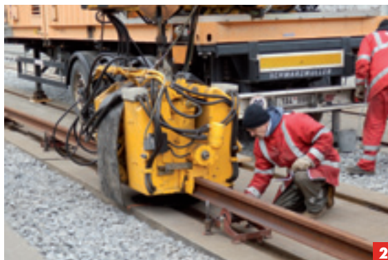
Pomocí mechanizace se svařovaná kolejnice po krocích táhne po rolnách směrem do místa uložení na trať. Pás může být dlouhý i několik stovek metrů.
