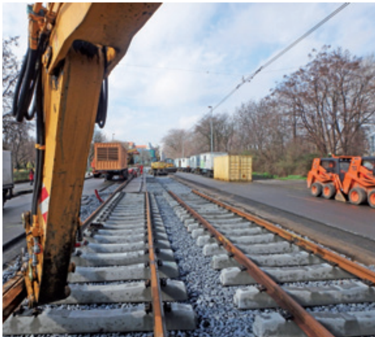
Pomocí mechanizace se svařovaná kolejnice po krocích táhne po rolnách směrem do místa uložení na trať. Pás může být dlouhý i několik stovek metrů.
