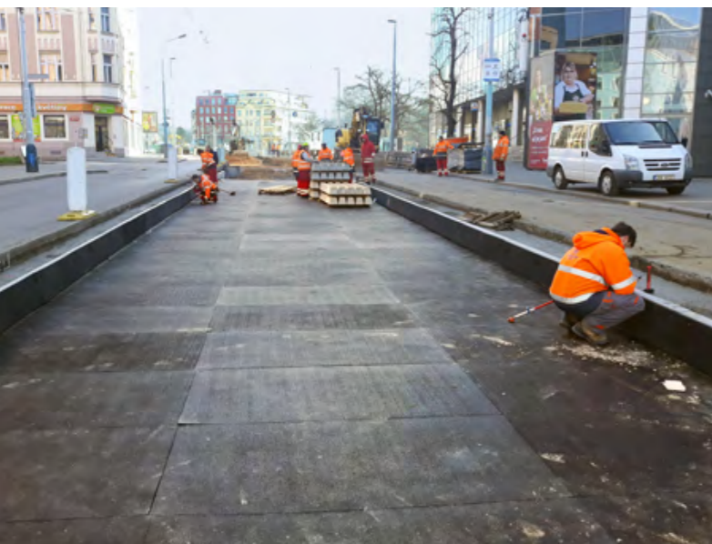
TAHLE ANTIVIBRAČNÍ VANA MÁ HLAVNÍ PODÍL NA SNÍŽENÍ NEGATIVNÍCH VLIVŮ TRAMVAJOVÉ DOPRAVY DO OKOLÍ. TLUMÍ VIBRACE A HLUK
