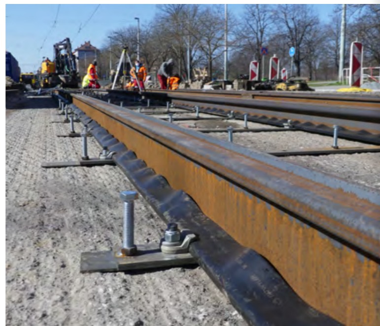
NA MOSTĚ PŘES ROKYTKU MUSELA BÝT ZŘÍZENÁ SPECIÁLNÍ KONSTRUKCE TRATI. DŮVODEM BYLA NÍZKÁ KONSTRUKČNÍ VÝŠKA NA MOSTĚ. NAD OCHRANOU IZOLACE MOSTU ZBÝVALO POUZE 24 CENTIMETRŮ K POVRCHU. PROTO BYLA POPRVÉ ZVOLENA KONSTRUKCE S VELMI TENKÝMI OCELOVÝMI PRAŽCI PŘÍŠROUBOVANÝMI K BETONOVÉ DESCE. K PRAŽCŮM BYLY PŘÍMO UPEVNĚNY KOLEJNICE POMOCÍ SPECIÁLNÍCH SVĚREK. NECHYBÍ ANI GUMA JAKO PROTIHLUKOVÉ A PROTIVIBRAČNÍ OPATŘENÍ
