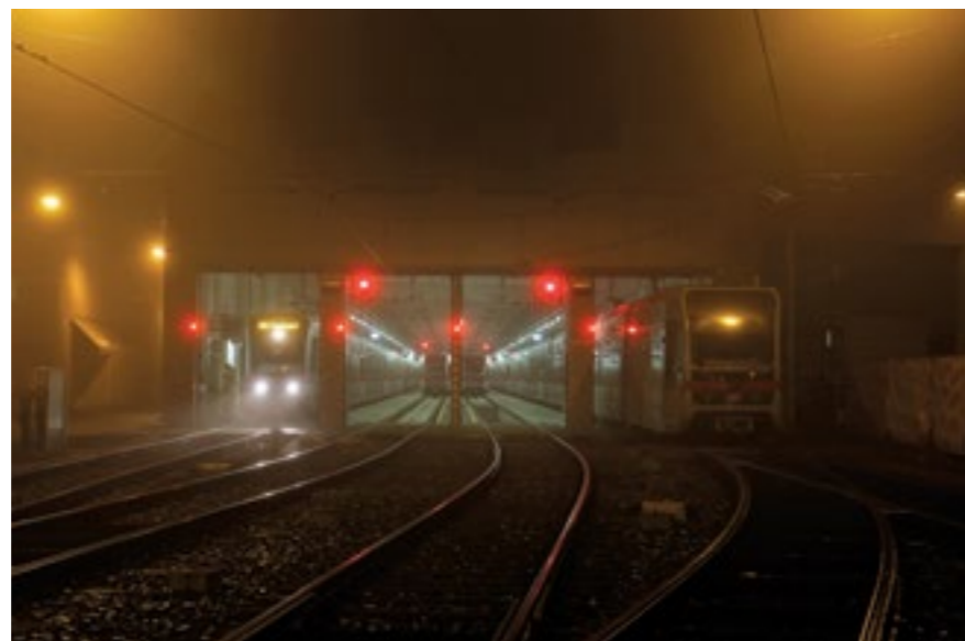
VÍDEŇ, RAKOUSKO. NA KOLEJÍCH DEPA ALTERLAA LINKY U6 ČEKÁJÍ 25. ŘÍJNA 2016 VLAKY TYPU TA T1 NA ODJEZD
