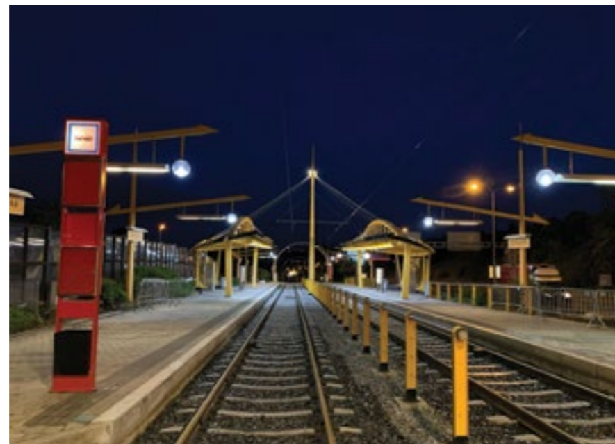
FINÁLNÍ KONTROLA OSVĚTLENÍ PROBĚHLA ČTYŘI DNY PŘED KONCEM VÝLUKY V NOČNÍCH HODINÁCH, ABY MOHLY BÝT PŘÍPADNÉ NEDOSTATKY PŘED SPUŠTĚNÍM PROVOZU DOLADĚNY
