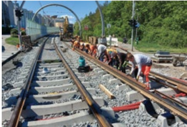
INSTALACE PROFILU KRUG NA PŘEJEZDU DO KLUKOVIC PROBIHALA PO PODBITÍ KOLEJÍ 12. KVĚTNA 2020
