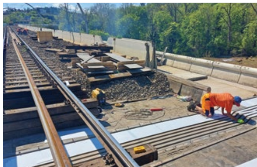
REPASE PLECHŮ A OPRAVA IZOLACÍ MOSTNÍCH ZÁVĚRŮ PROBÍHALA PO CELOU DOBU ZA PROVOZU STAVEBNÍCH MECHANISMŮ PO KOLEJI DO CENTRA
