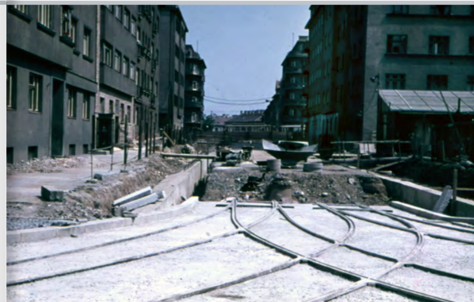
KOLEJOVÝ TROJÚHELNÍK V ULICI NA PANKRÁCI SMĚŘUJÍCÍ ZATÍM DO ROZKOPANÉ ULICE NA VESELÍ V ROCE 1968. PODOBNÉHO TROJÚHELNÍKU SE TU DOČKÁME ZNOVU
