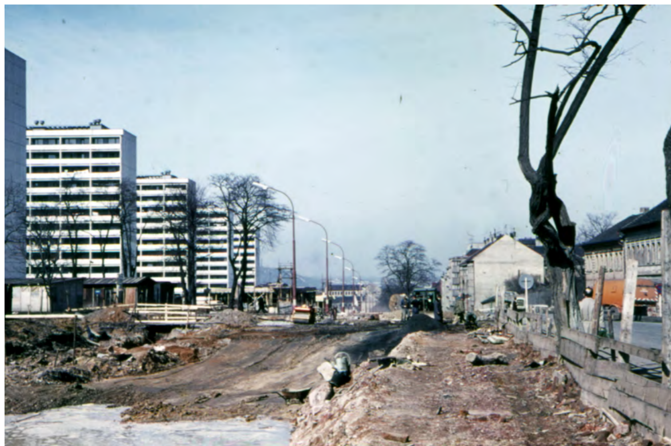
ROZESTAVĚNÁ ULICE NA PANKRÁCI V ROCE 1969 V POHLEDU OD HVĚZDOVY ULICE. ZAJÍMAVÝM DOJMEM PŮSOBÍ V PŘEDSTIHU POSTAVENÉ LAMPY VEŘEJNÉHO OSVĚTLENÍ NAD JEŠTĚ NEEXISTUJÍCÍ VOZOVKOU
