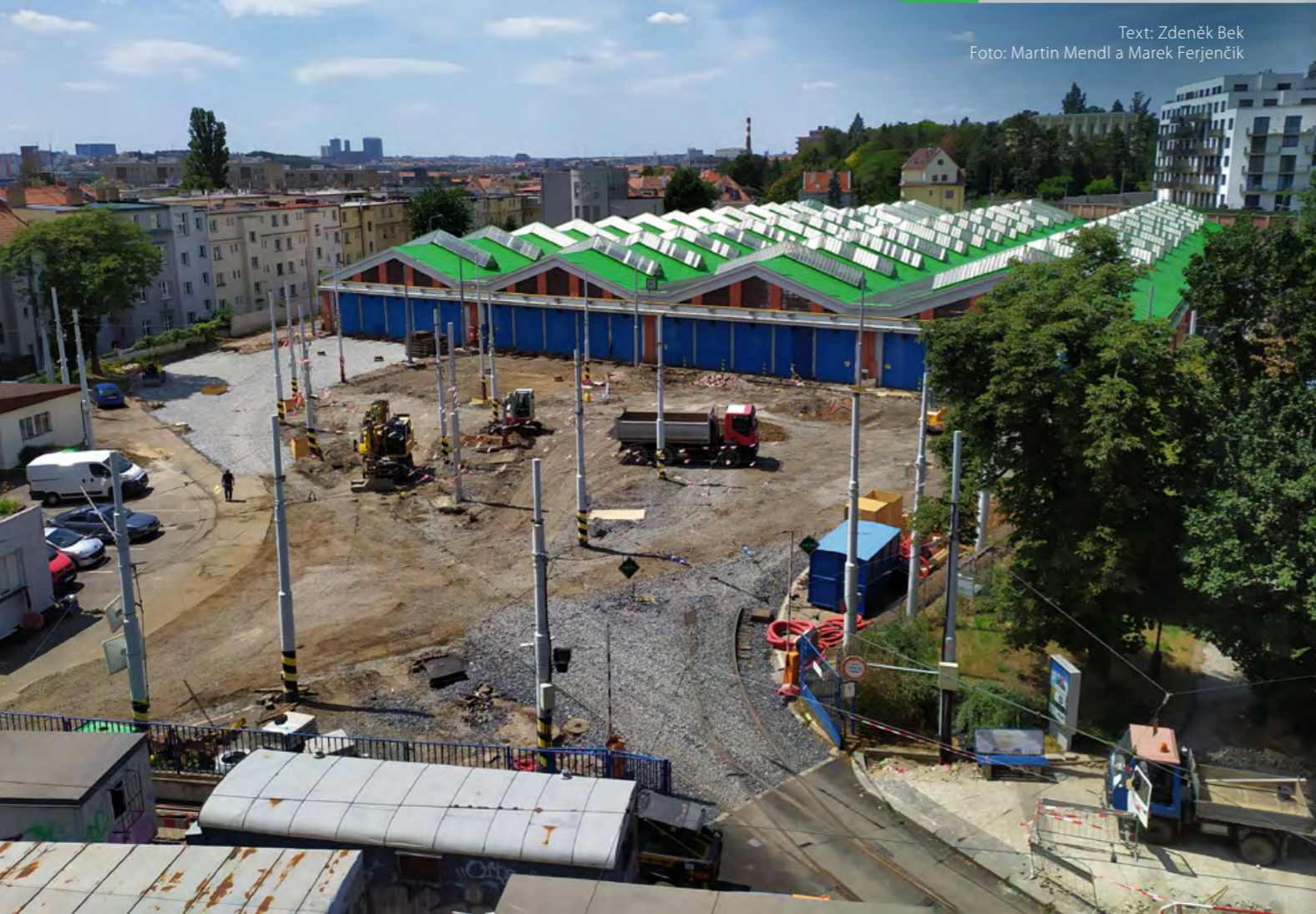
HARFA VOZOVNY BYLA SNEŠENA 10. ČERVENCE 2020 A VŠE SE NÁSLEDNĚ PŘIPRAVOVALO PRO POKLÁDKU KOLEJOVÝCH KONSTRUKCÍ
