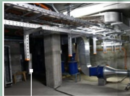
Modernizace se dočkaly i prostory ochranného systému metra, konkrétně přibyla nová vzduchotechnika a kabelové lávky
