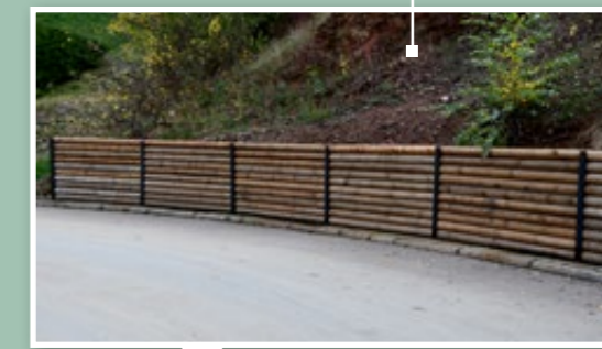
Opravena byla i opěrná stěna v blízkosti stanice metra u Centrálního parku
