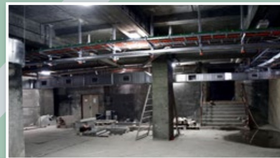
Modernizace se dočkaly i prostory ochranného systému metra, konkrétně přibyla nová vzduchotechnika a kabelové lávky
