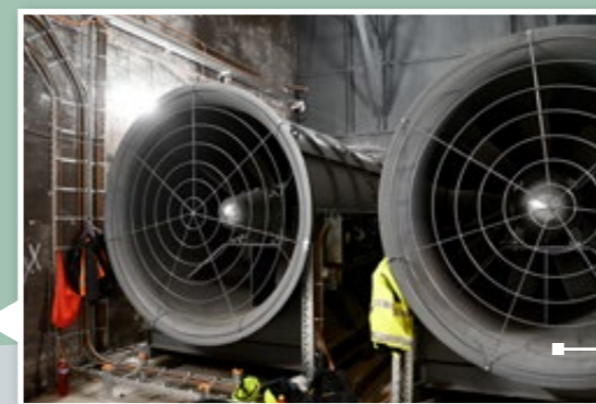
Vyměněna byla i vzduchotechnika včetně dvojice hlavních ventilátorů
