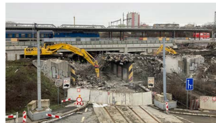
DEMOLICE MOSTŮ PŘINESLA LEDNOVOU VÝLUKU TRAMVAJOVÉ DOPRAVY FOTO: JAN LUTRYN
