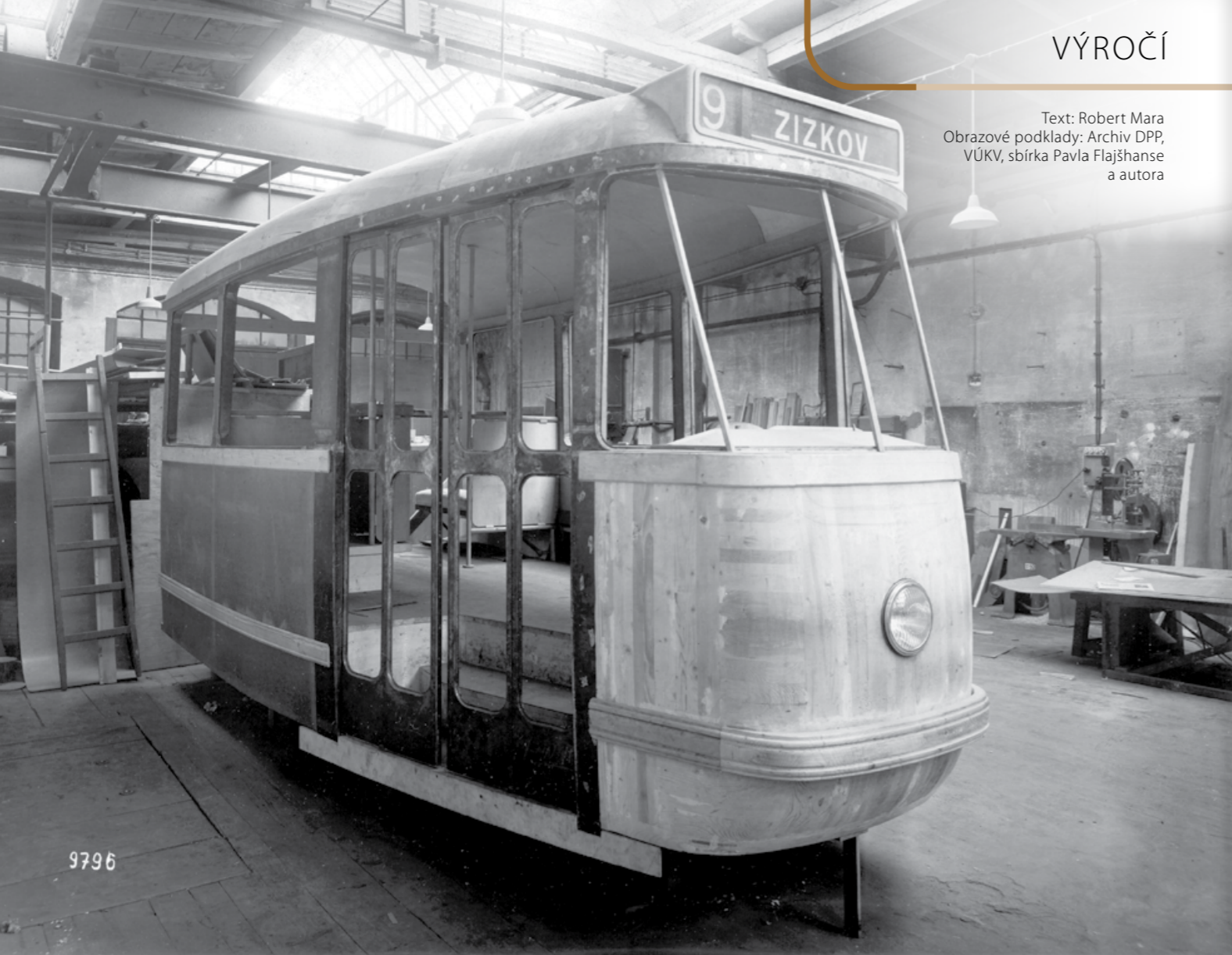
TVAROVÉ ŘEŠENÍ A VNITŘNÍ USPOŘÁDÁNÍ SKRÍNĚ BUDOUCÍ PRAŽSKÉ TRAMVAJE KONCEPCE PCC BYLO OVĚŘOVÁNO NA DŘEVĚNÉ MAKETĚ VE SKUTEČNÉ VELIKOSTI. NA SNÍMKU JE ZACHYCENA V PRŮBĚHU VÝROBY V ROZMEZÍ LET 1949 A 1950
