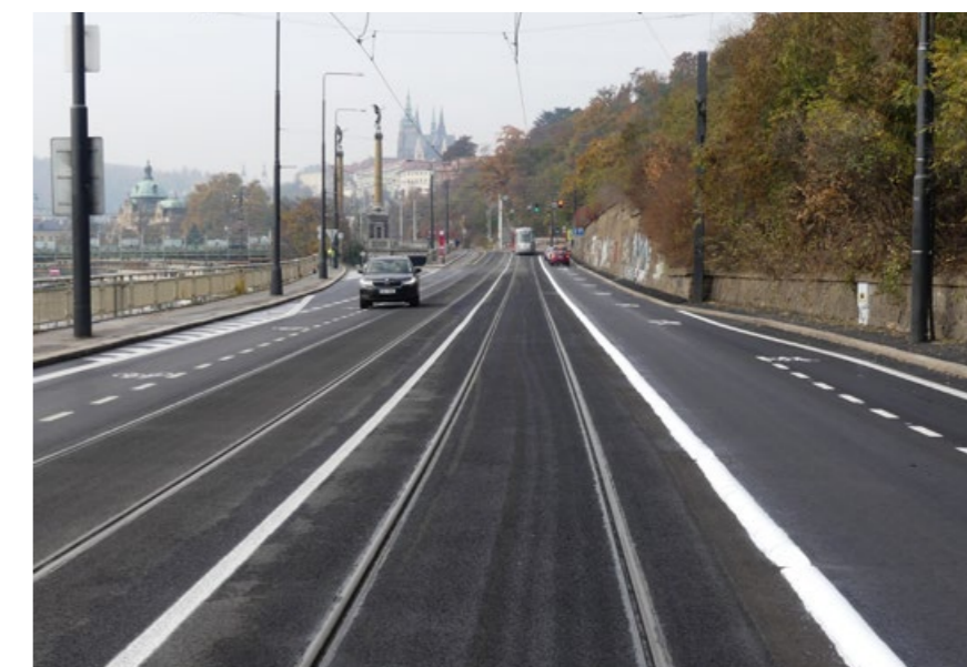
VÝZNAMNÝM POČÍNEM JE ODDĚLENÍ TRATI OD VOZOVKY NA NÁBŘEŽÍ EDVARDA BENEŠE. BYLO KVŮLI TOMU NUTNÉ POSUNOUT KOLEJE
