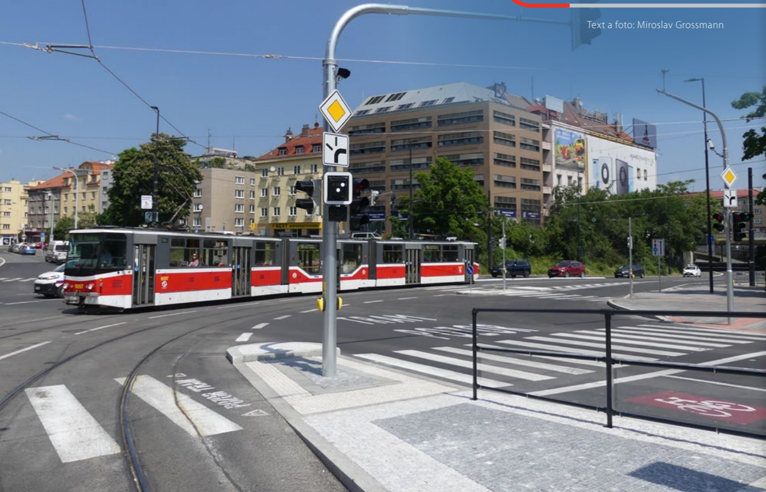
REKONSTRUKCE TRAMVAJOVÉ TRATI, DOPLNĚNÍ ODDĚLOVACÍCH TVAROVEK A ZAVEDENÍ PREFERENCE NA SSZ TÁBORSKÁ – NA PANKRÁCI PROBĚHLO NA JAŘE MINULÉHO ROKU
