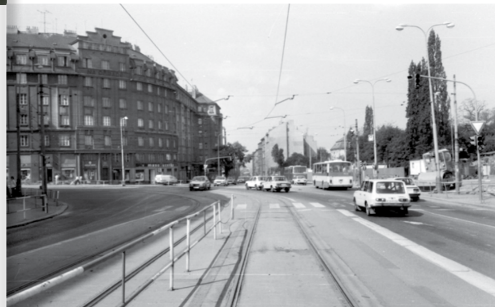
NA PRVNÍ POHLED NUDNÝ A NEZAJÍMAVÝ SNÍMEK BEZ JAKÉKOLIV TRAMVAJE. ANO, TAKTO VYPADALA KŘÍŽOVATKA OHRADA 5. KVĚTNA 1990. VIDÍME PROSTÝ KOLEJOVÝ OBLOUK Z BKV PANELŮ K ZASTÁVCE BISKUPCOVA, NEBOŤ PŘÍMÝ KOLEJOVÝ SMĚR BYL TEHDY TĚMĚŘ 13 LET ZRUŠEN. VPRAVO LZE TUŠIT VÝSTAVBU TRAMVAJOVÉ TRATI A PŘELOŽKU VOZOVEK KE KREJCÁRKU. VPRAVO VIDÍME IKARUS NA LINCE 136, KTERÝ PŘIJEL ODKLONEM PŘES SPOJOVACÍ. ZA NÍM POKRAČUJE KAROSA NA LINCE 207. PÁR TÝDNŮ POTÉ BYLA CELÁ KŘÍŽOVATKA KOMPLETNĚ UZAVŘENA A NÁSLEDOVALA PŘESTAVBA PRO NAPOJENÍ TRATI OD KREJCÁRKU
