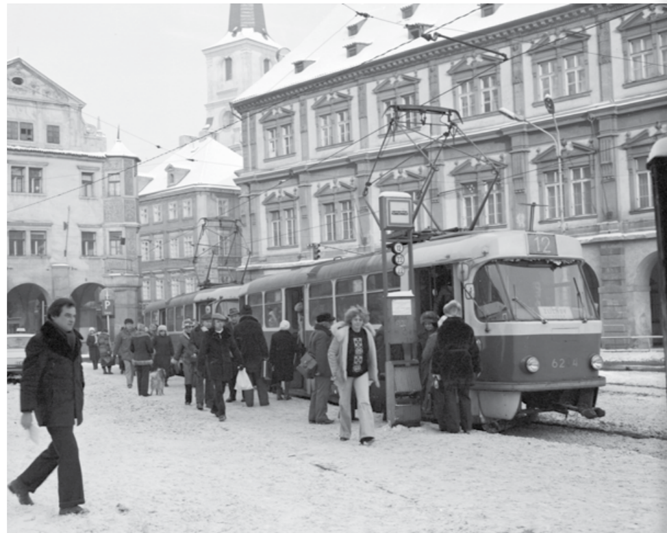
SOUPRAVA 2X T3 VEDENÁ VOZEM Č. 6204 NA LINCE Č. 12 NA MALOSTRANSKÉM NÁMĚSTÍ V ZIMĚ 1978/79. NA PŘEDNÍM ČELE JE PATRNÁ NEPŘEHLEDNUTELNÁ ANTÉNA STARŠÍ GENERACE RADIOSTANIC A TĚŽ NOVÝ DRŽÁK ZPĚTNÝCH ZRCÁTEK. FOTO: ARCHIV DPP
