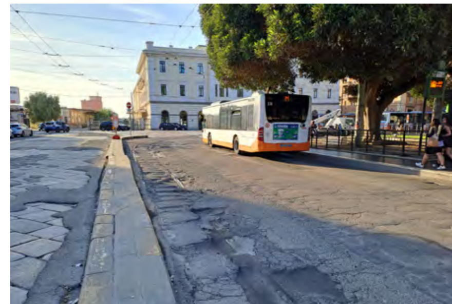
AUTOBUSOVÝ A TROLEJBUSOVÝ TERMINÁL MATTEOTTI PŘED ŽELEZNIČNÍ STANICÍ S PATRNÝMI STOPAMI PO ÚZKORZCHODNÉ TRAMVAJI
