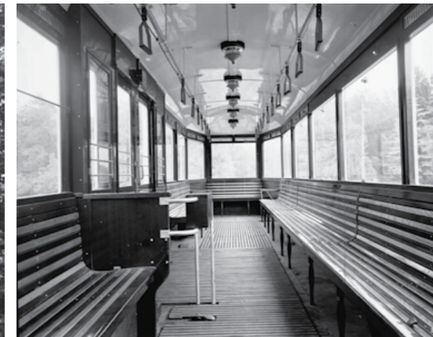
INTERIÉR NOVÉ PONORKY Č. 3048 PO DODÁNÍ Z VÝROBNÍHO ZÁVODU. VOZY BYLY TEHDY VYBAVENY STANOVÍŠTĚM PRŮVODČÍHO U STŘEDNÍCH DVEŘÍ
