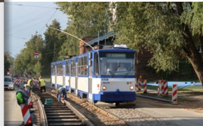
SOUPRAVA VOZŮ T6B5 NA LINCĚ 7 PROJÍŽDÍ PO REKONSTRUOVANÉM ÚSEKU. ZA POVŠIMNUTÍ STOJÍ SKUTEČNOST, ŽE ZATÍMCO TRAMVAJ JEDE PO NESPRÁVNÉ, TJ. PROTISMĚRNÉ KOLEJI, TYČOVÝ SBĚRAČ JE NAD SPRÁVNOU KOLEJÍ, KTERÁ JE VE VÝLUCE
