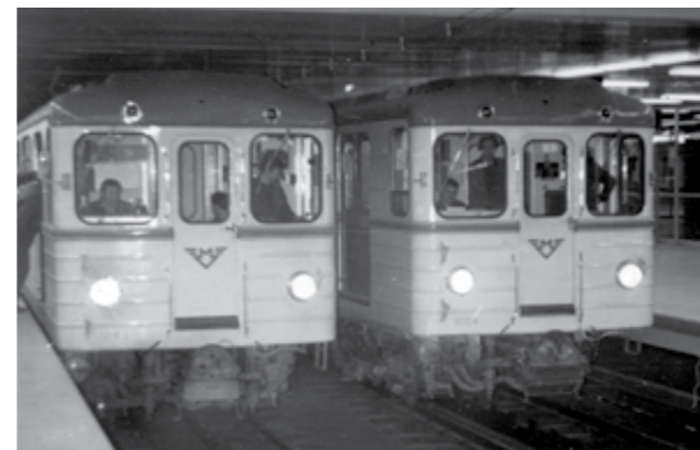
VZÁČNÝ SNÍMEK Z DYNAMICKÉ ZKOUŠKY NUSELSKÉHO MOSTU S VYUŽITÍM SOUPRAV METRA. DVOUVOZOVÉ SOUPRAVY SE PRÁVĚ PŘIPRAVUJÍ PRO SOUBĚŽNOU JÍZDU STEJNÝM SMĚREM
