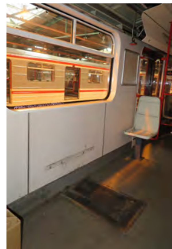
FÁZE REKONSTRUKCE ČELNÍHO VOZU, KDY PO ODSTRANĚNÍ „UDÍRNY“, Tedy SKŘÍNĚ ZABEZPEČOVAČE ARS, VZNIKNE MÍSTO PRO NOVÉ SEDAČKY
