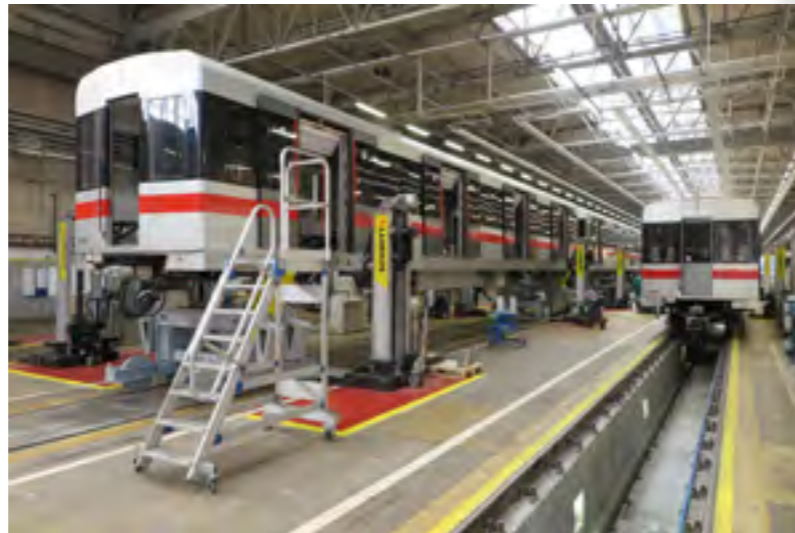
BĚHEM UPLYNULÉHO DESETELETÍ SE Podařilo KOORDINACÍ INVESTIC SPOLEČNOSTÍ SIEMENS A DPP VÝRAZNĚ ZLEPŠIT PRACOVNÍ PROSTŘEDÍ OPRAVÁRENSKÝCH PROSTORŮ DEPA KAČEROV. SERVISNÍ ČINNOST V RÁMCÍ SMLOUVY FULL SERVICE PROVÁDÍ SPOLEČNOST SIEMENS POMOCÍ SVÉHO VLASTNÍHO TECHNOLOGICKÉHO VYBAVENÍ V PROSTORÁCH PRONAJATÝCH OD DPP
