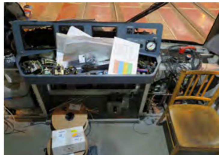
ÚPRAVA PULTU STROJVEDOUČÍHO SOUPRAVY ČELNÍCH VOZŮ 3191-3194 V DEPU HOSTIVAŘ
