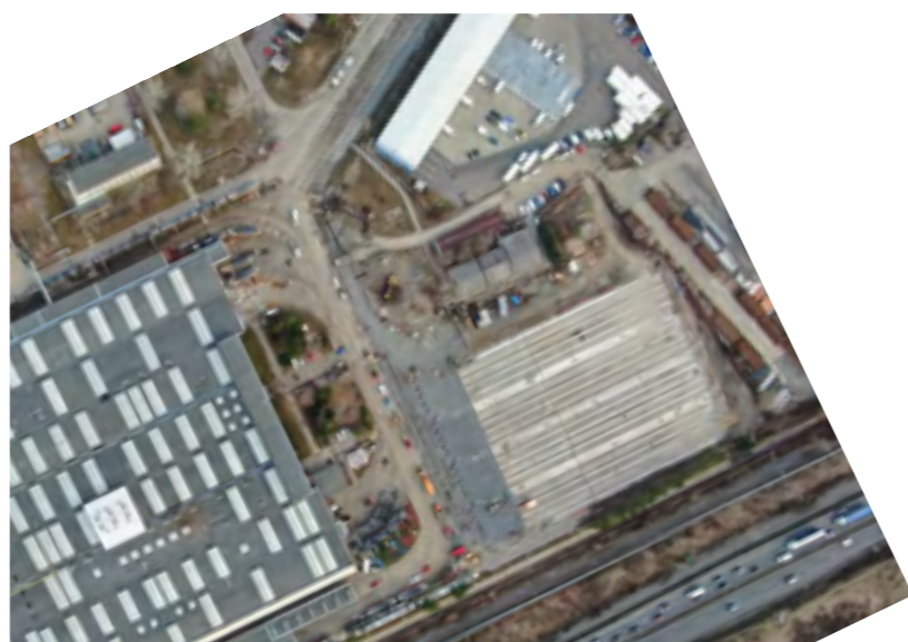
POHLED NA NOVOSTAVBU V ÚNORU 2019
