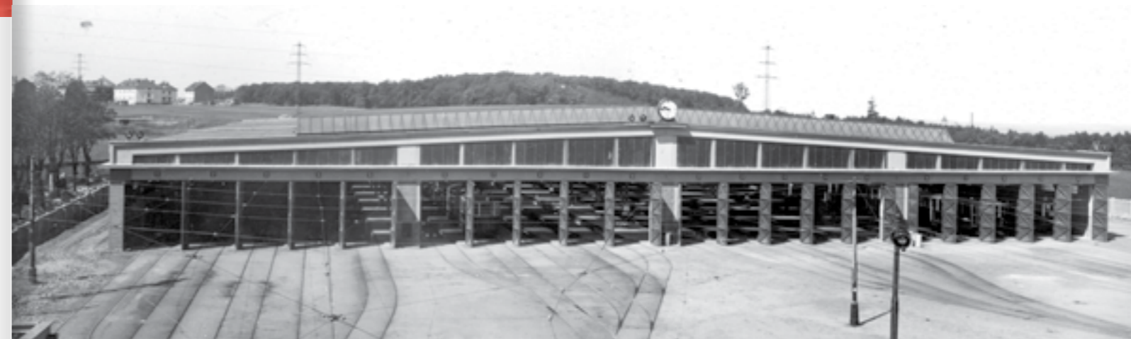
ČELO HALY VOZOVNY PO DOKONČENÍ V ROCE 1939
