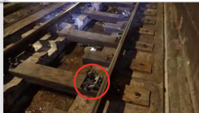
NA STARÉM DŘEVĚNÉM PRAŽCI JE VIDĚT KONZOLE PÁSU PO DEMONTÁŽI
