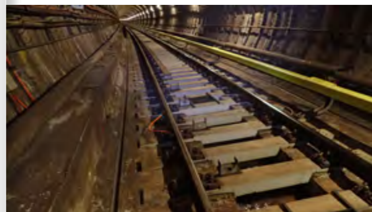
NA TOMTO SNÍMKU S JIŽ NOVÝMI PRAŽCI JE PATRNĚ ROZHRANÍ MEZI ÚSEKEM S A BEZ PA 135
