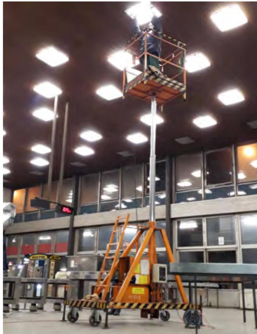
ÚDRŽBA OSVĚTLENÍ POMOCÍ PLOŠINY VE VESTIBULU STANICE KAČEROV
