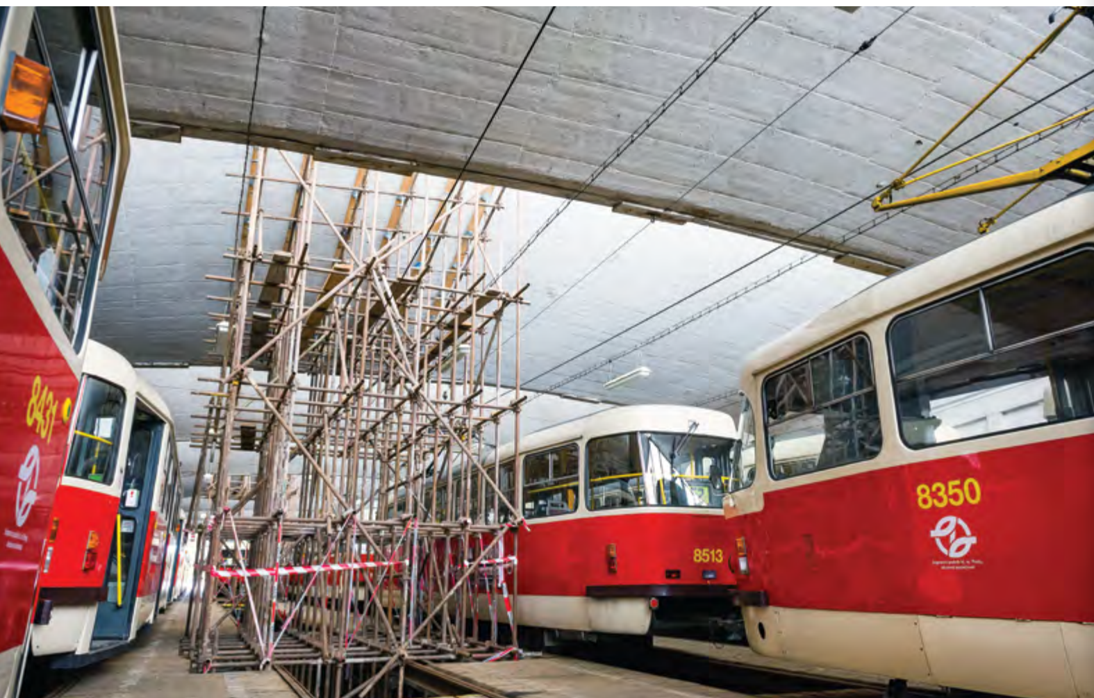
PRVNÍ PODPŮRNÁ KONSTRUKCE SE OBJEVILA VE TŘETÍ HALE V ROCE 2013
