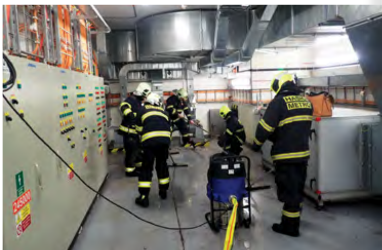
ZÁSAH S ČÍSLEM 55, STANICE METRA STŘÍŽKOV – TECHNICKÁ POMOC: ODSÁTÍ VODY Z TECHNICKÝCH PROSTOR STANICE PO HAVÁRII VODOVODU; POPRVÉ BYL VYUŽIT SPECIÁLNÍ VYSAVAČ Z VÝZBROJE TECHNICKÉHO AUTOMOBILU SCANIA
