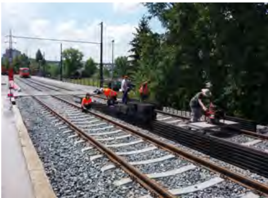
V ÚSEKU KOLEM VOZOVNY HLOUBĚTÍN SE ZA PROVOZU TESTUJE NOVÁ PROTIHLUKOVÁ CLONA Z GUMOVÝCH KVÁDRŮ, JEJÍŽ VÝSTAVBA JE NA SNÍMKU ZACHYCENA
