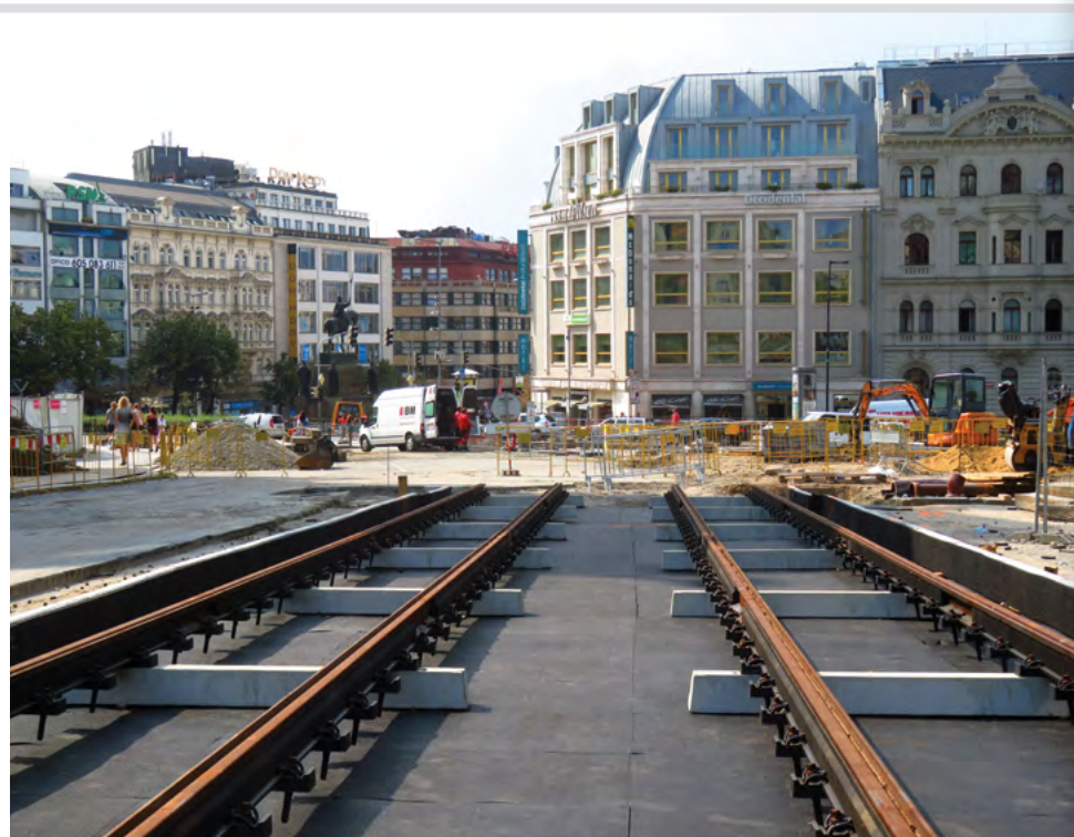
SNÍMEK ZE STAVBY, MONTÁŽ KOLEJÍ (SRPEN 2018)
