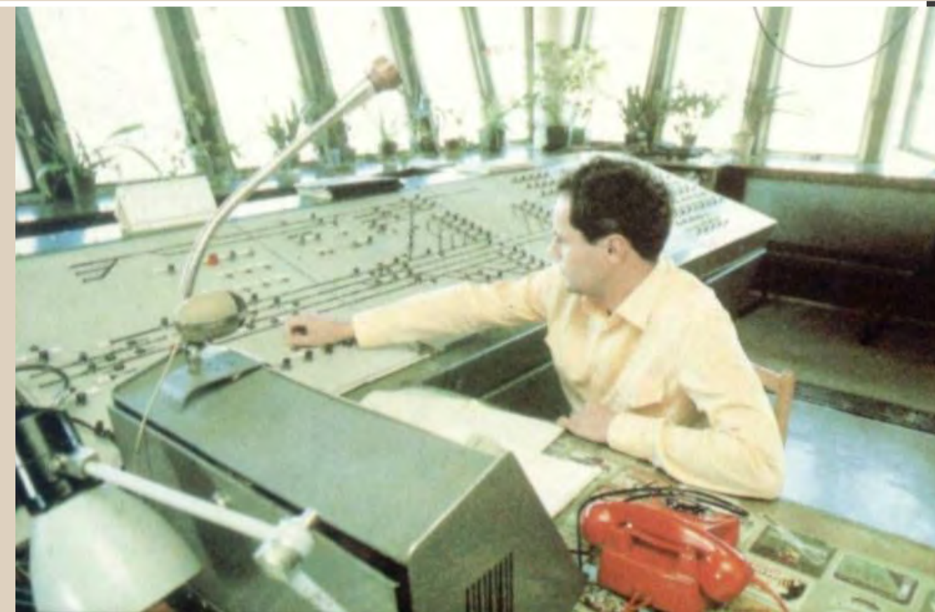
OVLÁDACÍ STŮL STANIČNÍHO RELÉOVÉHO ZABEZPEČOVACÍHO ZAŘÍZENÍ AŽD 71 V DEPU KAČEROV
