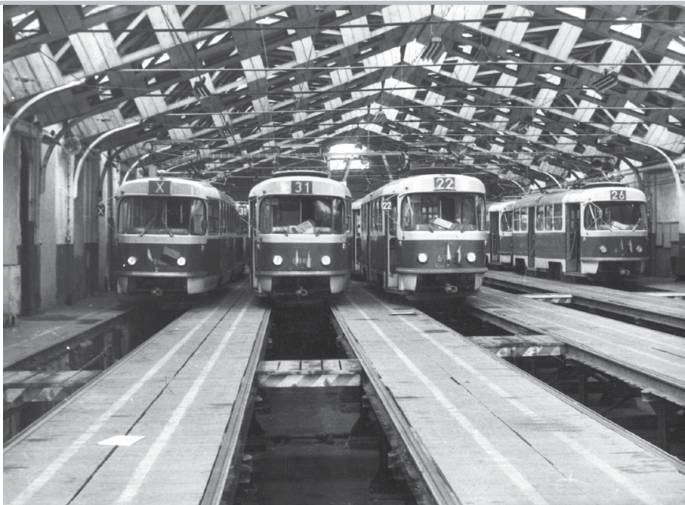
ČTVRTÁ HALA VOZOVNY S VOZY T3 V ROCE 1990
