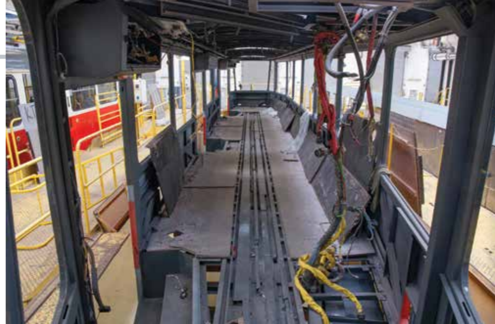
TRAMVAJ VE FÁZI MONTÁŽE ELEKTROVÝZBROJE (DUBEN 2015)
